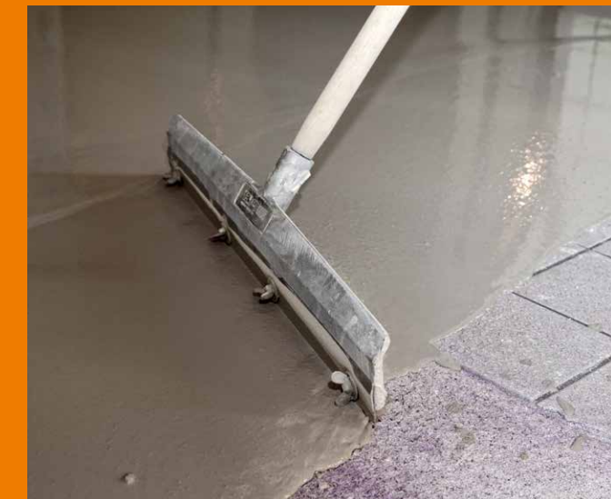
Mit einem Stift- oder Kufenrakel lassen sich alle PCI-Spachtelmassen angenehm im Stehen verteilen.
