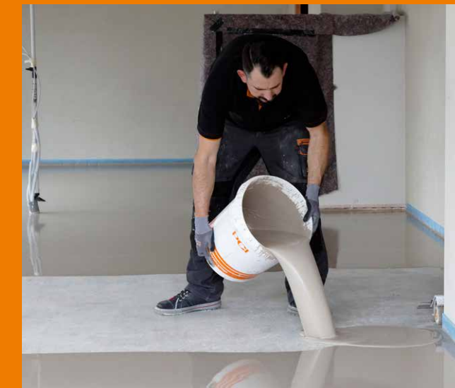
Entspanntes Arbeiten: Anrühren – Ausgießen – Läuft!
