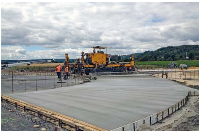
Bild 7: Herstellung einer Beton-Kreisverkehrsfläche mit Fertiger
