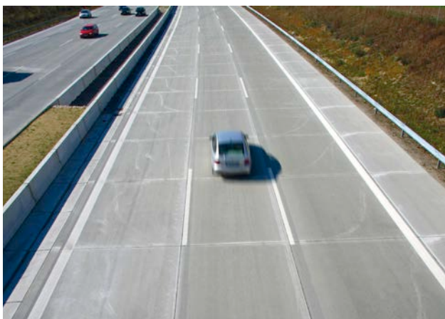
Bild 1: Betonfahrbahndecke im Fernstraßenbau
