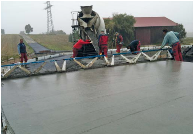
Bild 6: Herstellung einer Beton-Kreisverkehrsfläche im Handeinbau mit Rüttelbohle
