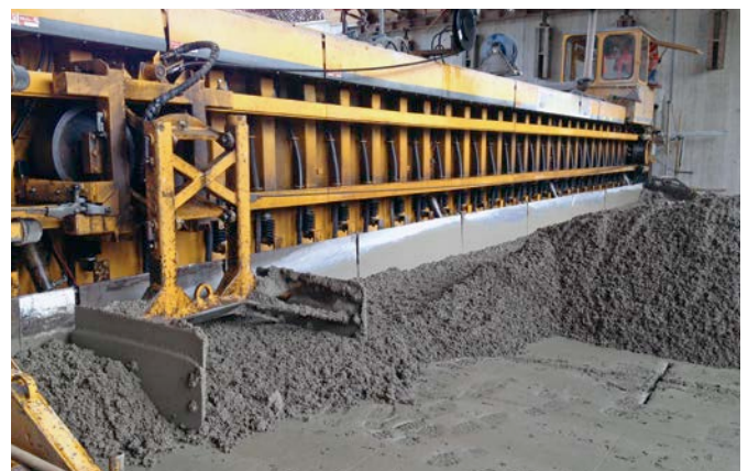
Bild 3: Einbau des Oberbetons, zweischichtige Bauweise
