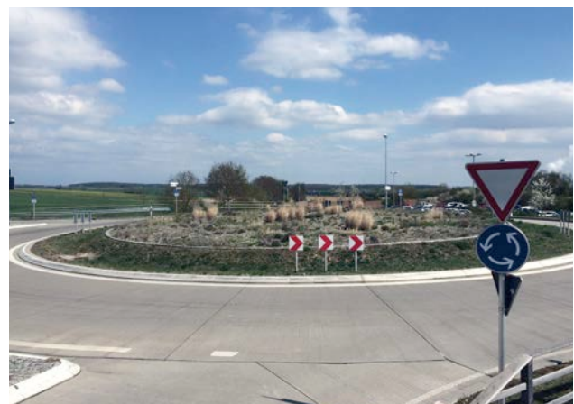
Bild 2: Betonfahrbahndecke im kommunalen Straßenbau
