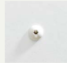
Standardschraubenkopf für andere Bekleidungsmaterialien
