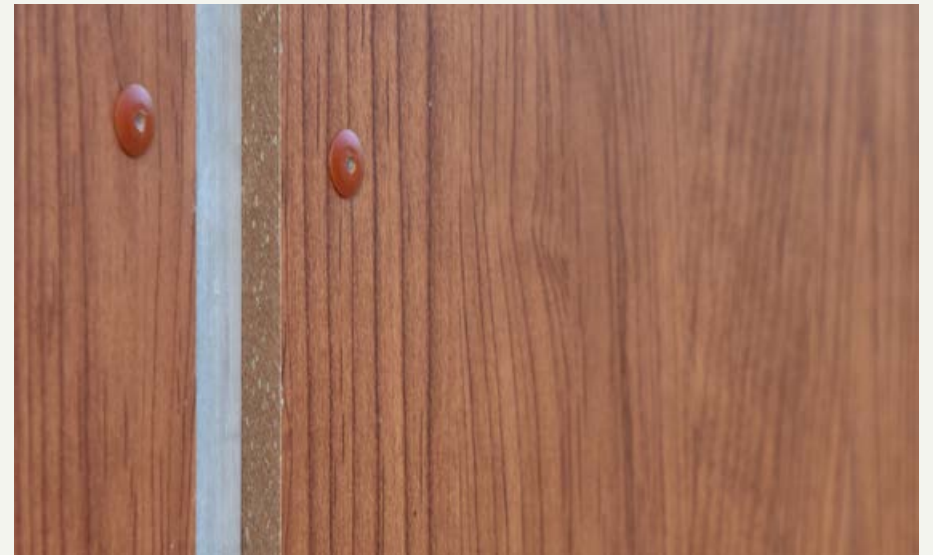
Blindnieten passen farblich zum Plattendesign
