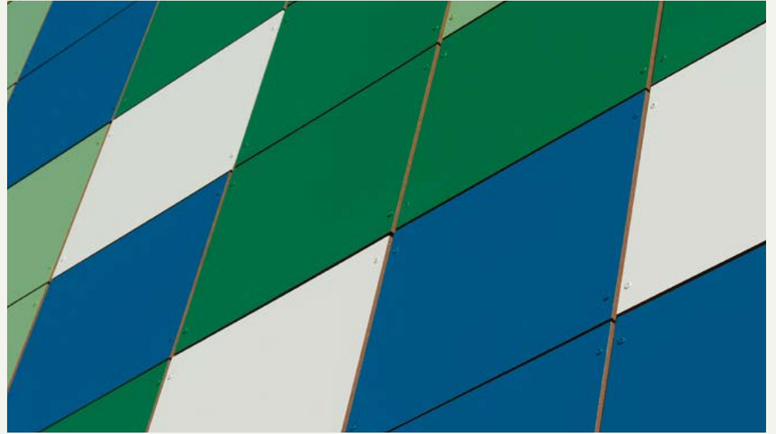
Schrauben passen farblich zum Plattendesign
