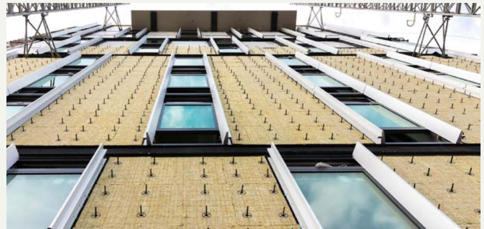
Aufbau der vorgehängten hinterlüfteten Fassade
