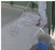
6. Eine zweite Schicht Triflex ProTect wird aufgebracht.
