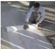
5. Das Triflex Spezialvlies wird vollflächig und blasenfrei eingearbeitet.
