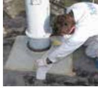
3. Zuerst werden alle Details mit Triflex ProDetail abgedichtet.
