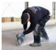
2. Absperschnitte 10 cm links und rechts vom Riss setzen.
