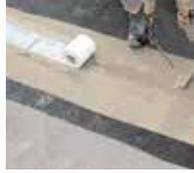
3. ... Fugen werden mit Triflex ProDetail abgedichtet.
