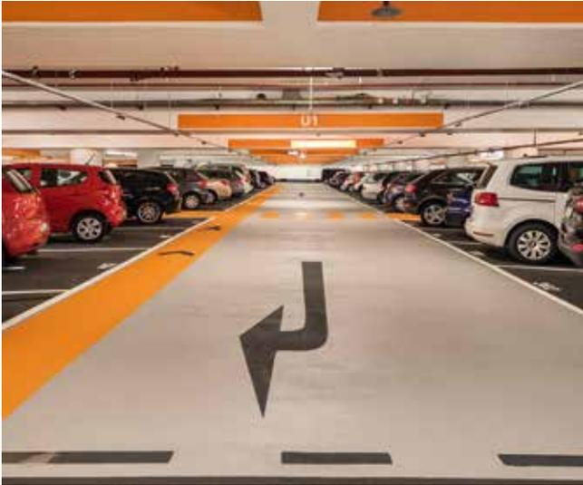
**Triflex DeckFloor** ist ein wasserdichtes Dickschichtsystem mit statischer Rissüberbrückung. Das System ist mechanisch hoch belastbar und speziell für stark frequentierte Zwischendecks, die natürlich belüftet sind, ausgelegt. Das OS 8-Beschichtungssystem kann auch in frei bewitterten Bereichen eingesetzt werden.
