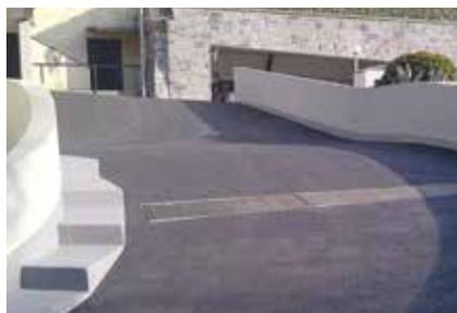
Da sich das Material mit dem Untergrund verbindet, ist auch im Falle einer mechanischen Beschädigung eindringender Feuchtigkeit der Weg versperrt. Und Bauwerksbewegungen, die vor allem im Schnittpunkt von horizontalen und vertikalen Bauteilen vorkommen, gleicht das riss-überbrückende Abdichtungssystem einfach aus.
