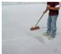
9. Nach Aushärtung der Beschichtung wird der Überschuss entfernt.
