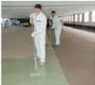
4. Die Beschichtung Triflex Cryl Finish 209 gleichmäßig auftragen.
