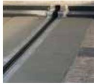
11. Nun kann das Oberflächenschutzsystem bis ans Fugenprofil herangeführt werden.
