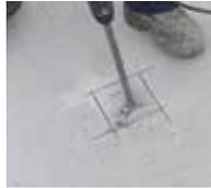
2. Ausbrüche und Schlitz für Verteilerdosen, Sensoren und Kabel werden eingefräst.
