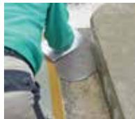
8. Mit Triflex DeckFloor Mörtel werden die Zwischenräume der Heizlamine ausgeglichen.
