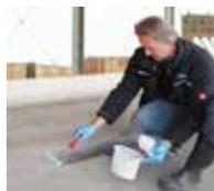
3. Die Fläche wird grundiert, Absperschnitte und Risse vergossen.
