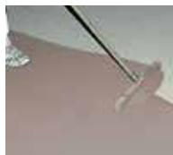
4. ... wird mit einem Zahngummirakel gleichmäßig aufgezogen.
