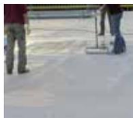
2. Anschlüsse und Fläche mit Primer grundieren.
