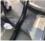
9. Die Profilvertiefung für das Triflex ProJoint Dehnungsband wird mit Triflex ProJoint Cleaner gereinigt
