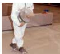
8. Für einen besseren Haftverbund wird eine zusätzliche Nutzschrift mit Triflex ProPark aufgetragen und mit Quarzsand abgestreut.
