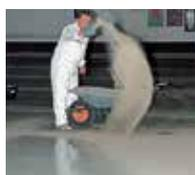
5. ... und im frischen Zustand mit Quarzsand im Überschuss abgestreut.
