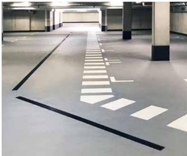
**Triflex DeckCoat** ist ein wasserdichtes Dünnschichtsystem für gering frequentierte Parkdeckflächen und Stellplätze. Das speziell für Zwischendecks entwickelte System aus Polymethylmethacrylatharz (PMMA) bietet einen einfachen, farbig gestaltbaren Schutz und erhöht die Rutschhemmung. Anschlüsse, Fugen und Details werden als vliesarmierte Abdichtung ausgeführt.
