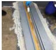
7. Die Triflex ProJoint Fugenprofile werden entlang der Fuge vollflächig verklebt.
