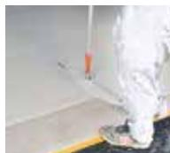
4. und mit einem Triflex Zahngummi-Rakel gleichmäßig verteilt.
