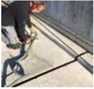
1. Der Untergrund wird geätzt und dann geschliffen oder kugelgestrahlt.
