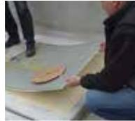
5. ... und mit den Triflex HeatTec Heizlaminaten hohlraumfrei verklebt.
