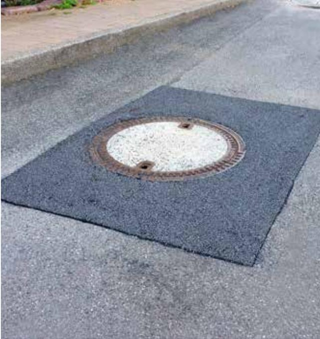
Triflex Asphalt Repro 3K ist ein 3-komponentiges, schnell reaktives Ausbesserungsprodukt auf Polymethylmethacrylatharzbasis (PMMA). Der Reparaturmörtel lässt sich für Schlaglöcher, Ausbrüche an Gullys, Treppen oder Aufkantungen sowie zum Verfüllen beispielsweise von Fugen und Bohrungslochern oder zum Erstellen von kleinen Rampen und Abschrägungen einsetzen.
