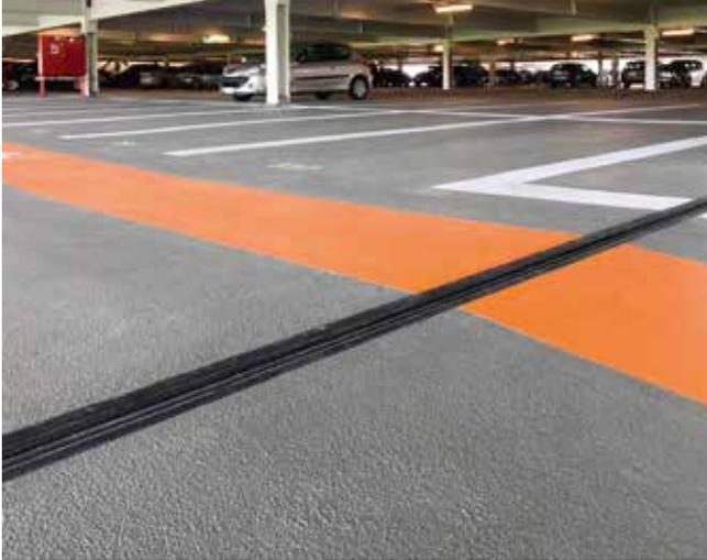
Topdecks und Parkdecks sind oft große Flächen, die starken Beanspruchungen ausgesetzt sind. Bewegungsfugen nehmen die Bewegungen aus Setzungen, Dehnungen, Verschiebungen und zusätzliche Verkehrslasten auf. Nur wenn auch diese Fugen sicher abgedichtet sind, kann die Parkdeckabdichtung oder -beschichtung den Betonuntergrund sicher schützen.
