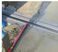
8. Beim aufgesetzten Profil (Variante 2) wird der Höhenversatz mit Triflex Ceryl RS 240 ausgeglichen.
