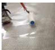
6. Die Armierung wird mit Triflex Cryl Primer 287 getränkt und mit der Rolle blasenfrei angedrückt.
