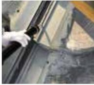
10. Anschließend wird das Dehnungsband mit Triflex ProJoint Fix verklebt.
