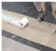
3. ... Fugen werden mit Triflex Than R 557 thix abgedichtet.
