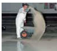
5. Die frische Beschichtung wird mit Quarzsand abgestreut.
