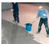
4. Die Grunderspachtelung aus Triflex Pox Primer 116+ gefüllt mit Quarzsand wird aufgetragen ...
