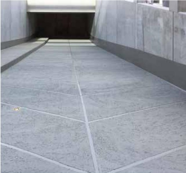
Das System **Triflex HeatTec** wurde als Flächenheizsystem für Ein- und Ausfahrtsbereiche von Parkbauten entwickelt. Es ist entsprechend den in diesen Bereichen hohen mechanischen und chemischen Anforderungen belastbar. Auch für andere bege- oder befahrbare Bereiche im Außenbereich kann das Heizsystem Triflex HeatTec zum Einsatz kommen. Dazu zählen z.B. Bahnsteige, Hubschrauberlandeplätze, Laubengänge, Balkone, Treppenanlagen u. v. m.
