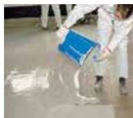
3. Der Verlaufmörtel Triflex DeckFloor wird aufgetragen ...
