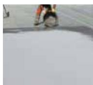
8. In die frische Beschichtung wird Quarzsand oder Hartkorn fein eingestreut.
