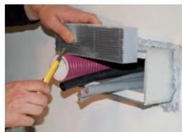
**8.** Nach der Kabelinstallation werden die EasyFoam - Stopfen einige mm größer als benötigt zugeschnitten, damit sie hinterher fest in der Öffnung sitzen.
