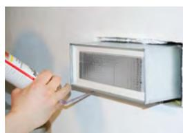
**5.** Die Kabelbox wird dann in Wandtiefe vollständig eingeschäumt. Das Spaltmaß darf maximal 2 cm betragen.
