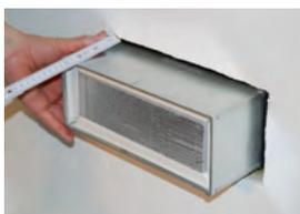
**4.** Kabelbox waagrecht in die Öffnung einsetzen, dass nirgends mehr als 8,5 cm aus der Wand stehen. Die Grafitstreifen müssen innerhalb der Wand sein.
