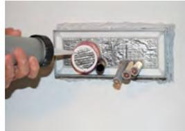
**10a.** Danach werden alle Restöffnungen mit einem dauerelastischen Dichtstoff, wie z.B. Silikon oder Acryl, rauchdicht verschlossen.
