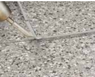
Schweißschnüre für Zonierungen und die Cleantech Version
