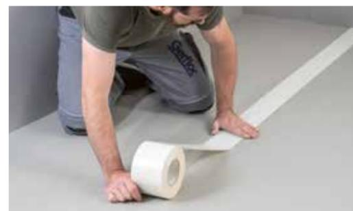
Bringen Sie das HOP-Nahtband an der Nahtstelle der Bahnen an. Code: 059E/Verpackung: 50 lfm/Karton
