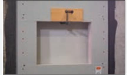
Nach der Grundierung der Betonwand Dickbeschichtung anrühren und auftragen. MEAFIX PRO an Wand kleben und gegen Verrutschen sichern.
