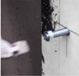
Schwerlastdübel bis zur Hälfte in Betonwand einschlagen
