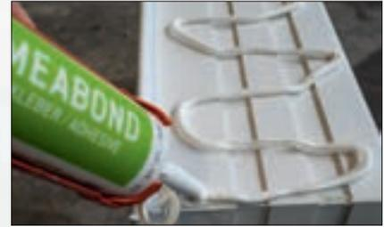
Kleber gleichmäßig auf Dämmstoffrückseite aufbringen. Anschließend an Wand anpressen, dabei nach Fensterzarge ausrichten, nach Möglichkeit Perimeter-Abdeckrahmen zur Positionierung einschieben (ggf. klemmen). Gegen Absenken abstützen.
