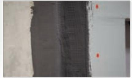
Montagekleber MEABOND auf Perimeter-Abdeckrahmen aufbringen und diesen anschließend gleichmäßig in Öffnung einschieben. MEAFIX PRO umlaufend mit 2-lagiger mineralischer Dickbeschichtung und eingebettetem Glasseidengewebe abdichten.
