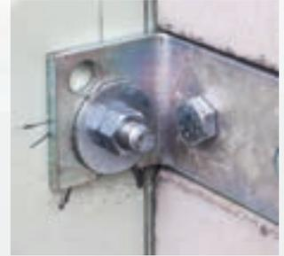
Anschließend alle Muttern wechselseitig vollständig festziehen
