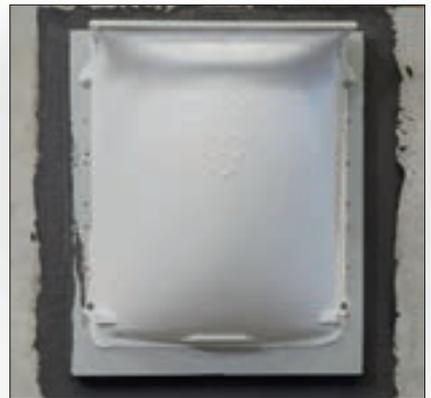
Dämmstoffdübel auf markierten Befestigungspunkten (abhängig vom Lichtschachttyp) eindrehen. Kleber MEAAQUA gleichmäßig auf Lichtschachtflansch auftragen. Lichtschacht mit eingelegtem Gitterrost oben einhängen, anschließend Schrauben oben und unten eindrehen und Lichtschacht damit fixieren. Fertig!
