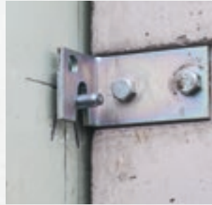
Einhängen des Lichtschachts an die Dübel
