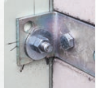
Anschließend alle Muttern wechselseitig vollständig festziehen
