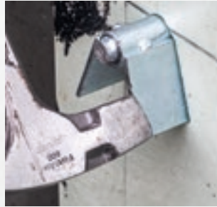
Einschlagen des Befestigungselements
