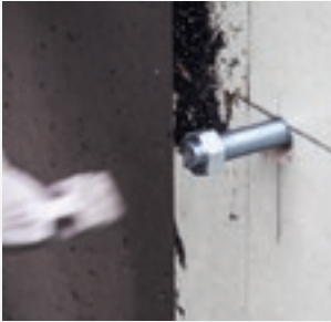
Schwerlastdübel bis zur Hälfte in Betonwand einschlagen
