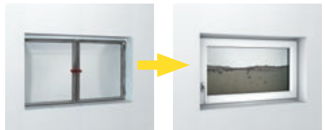
Beispiel: Umbau Stahlfenster mit Glas auf hochwertiges Dreh-Kipp-Fenster
