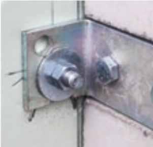
Anschließend alle Muttern wechselseitig vollständig festziehen
