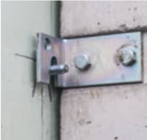
Einhängen des Lichtschachts an die Dübel
