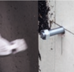
Schwerlastdübel bis zur Hälfte in Betonwand einschlagen
