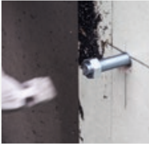
Schwerlastdübel bis zur Hälfte in Betonwand einschlagen
