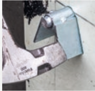
Einschlagen des Befestigungselements
