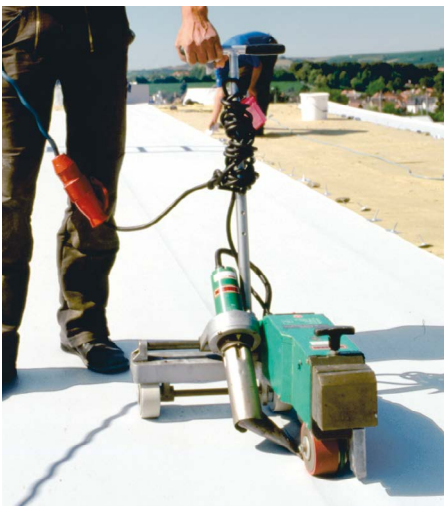
Sichere und rationelle Verschweißung mit Heißluft
