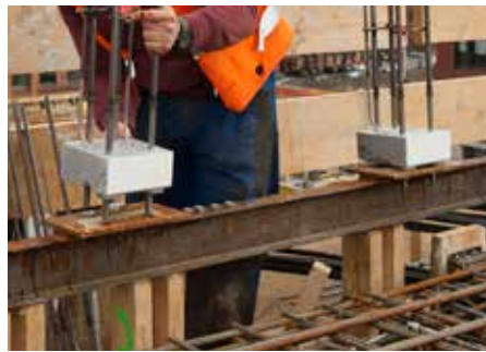
Abb. 1: Isokorb® auf Stahlschablone fixieren
