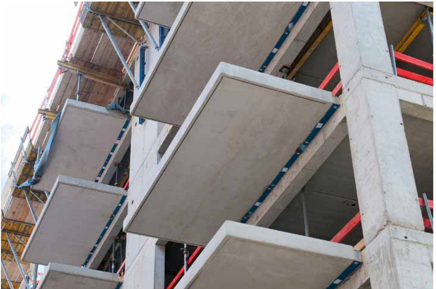
Abb. 3: Ausgeschaltete Balkonplatten
