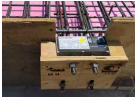
Abb. 1: Isokorb® ausrichten und fixieren mittels Einbauschablone
