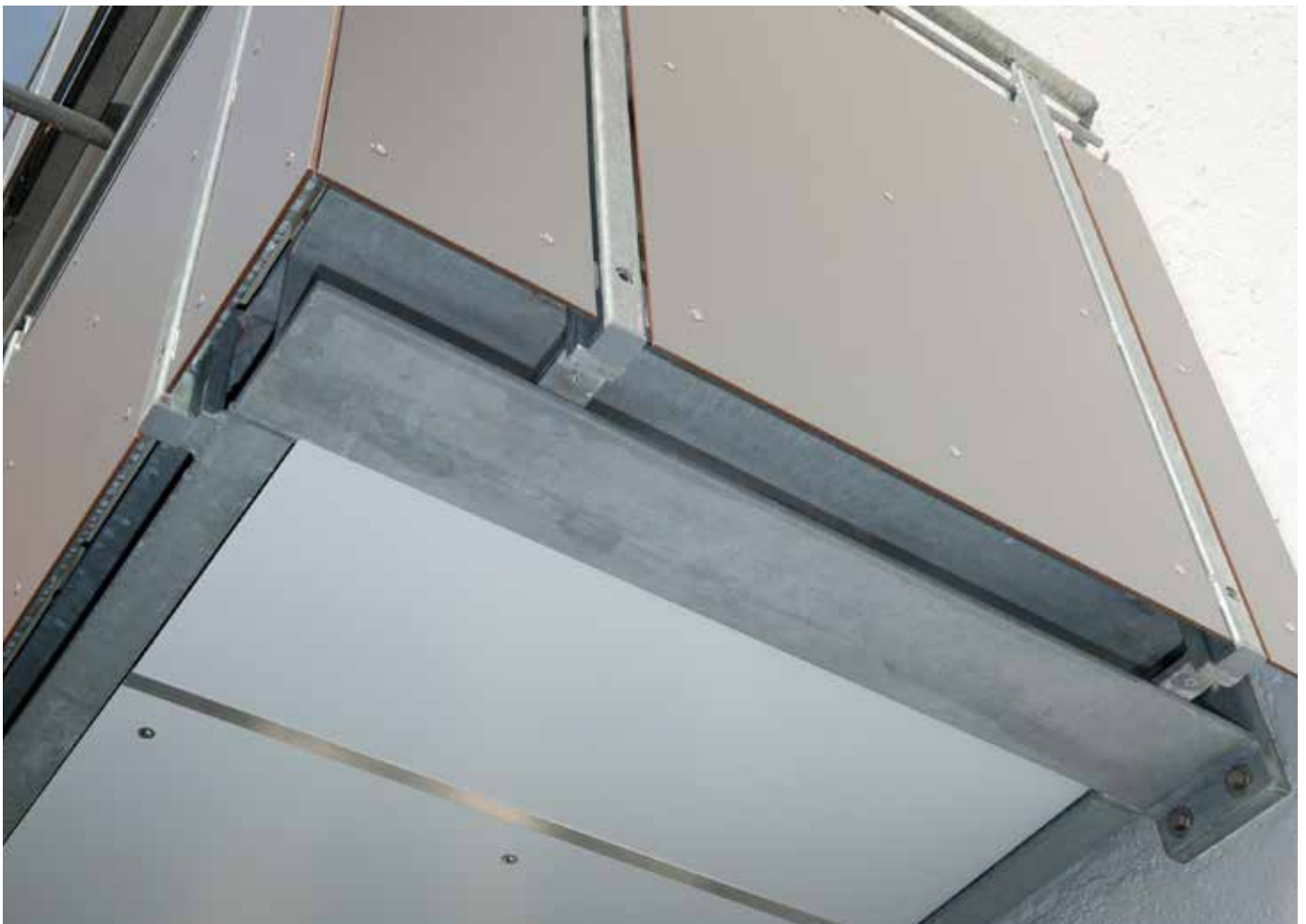
Abb. 3: Vorgefertigter Stahlbalkon mit Isokorb® verschrauben
