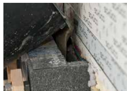
Abb. 2: Isokorb® einkleben und Vergusstasche kraftschlüssig verfüllen
