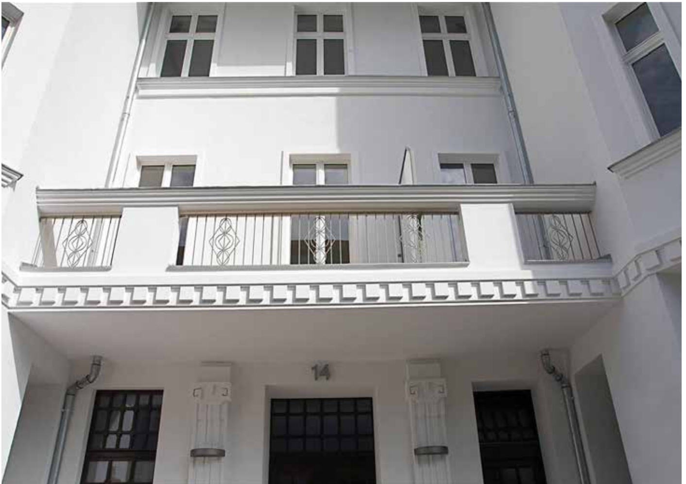
Abb. 3: Denkmalgerecht sanierter und thermisch getrennter Balkon
