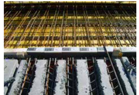
Abb. 2: Oberseitige Vergusstaschen in den Hohlkörperdecken mit Übergreifungsstößen
