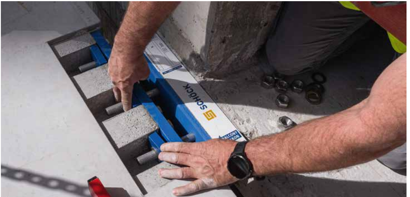
Abb. 5: Trockene unterstützungsfreie Verschraubung von Balkon- mit Deckenseite
