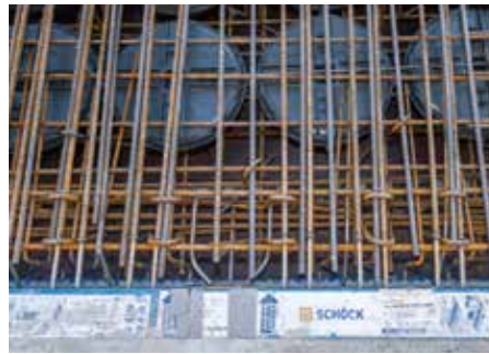
Abb. 1: Isokorb® in Bewehrung einsetzen
