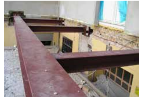
Abb. 2: Thermisch getrenntes Tragwerk des neuen Balkons
