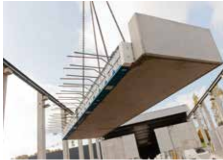
Abb. 1: Anlieferung des Fertigteils auf die Baustelle
