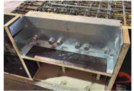
Abb.2: IQ K-B Teilset Balkon und Bewehrung verlegen. Anschließende Betonage
