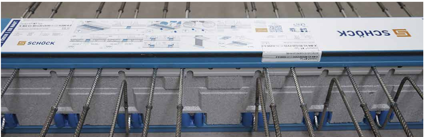
Die wichtigsten Hinweise zum Einbau sind auf dem Aufkleber abgedruckt, die Pfeile geben die Einbaurichtung an
