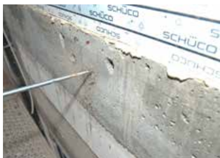
Abb. 1: Bohrungen in Decke herstellen und reinigen
