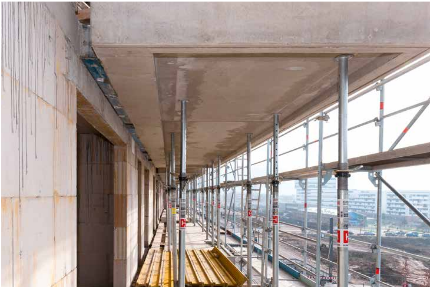
Abb. 3: Balkonplatten bis zur Endfestigkeit abstützen
