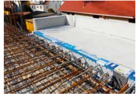
Abb. 2: Einbau in Decke, Abstützen des Fertigteils
