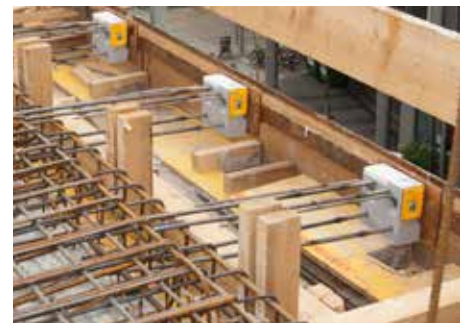
Abb. 2: in Deckenbewehrung einschieben, Stahlschablone gewährleistet den exakten Einbau
