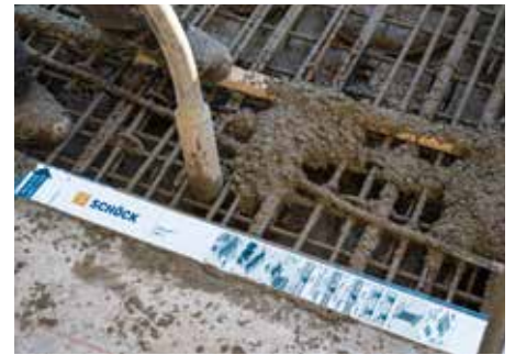
Abb.2: Decke und Balkonplatte betonieren
