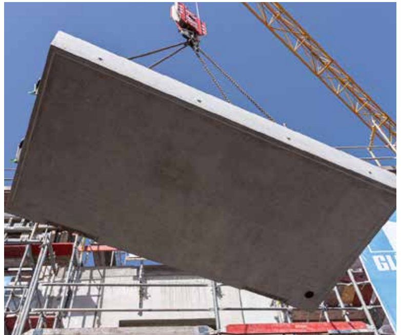
Abb. 4: Fertigteilbalkon wird mit Kran an Decke positioniert
