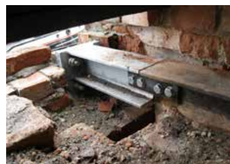
Abb. 2: neuer Balkonanschluss an bestehendem Stahlträger
