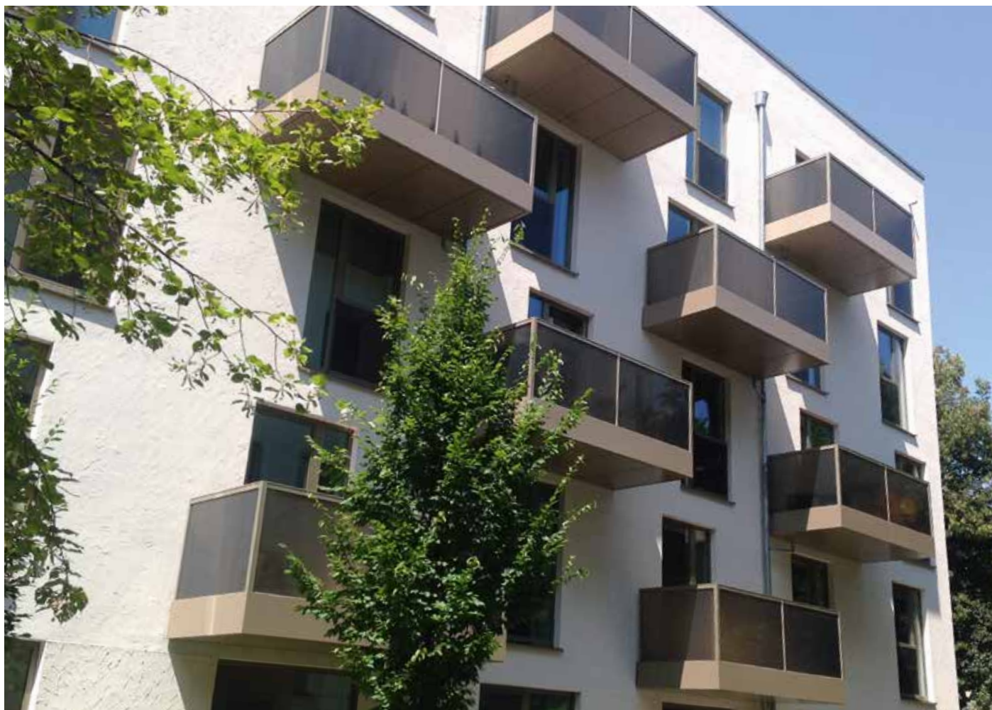
Abb. 3: Sanierungsobjekt mit thermisch getrennten Balkonen
