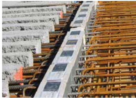
Abb.1: In Bewehrung eingebauter Isokorb®
