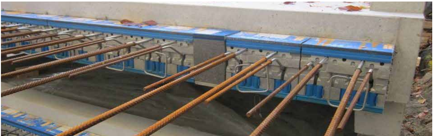
Transportankerlücke nachträglich mit Z verschlossen; durchgehende Dämmebene
