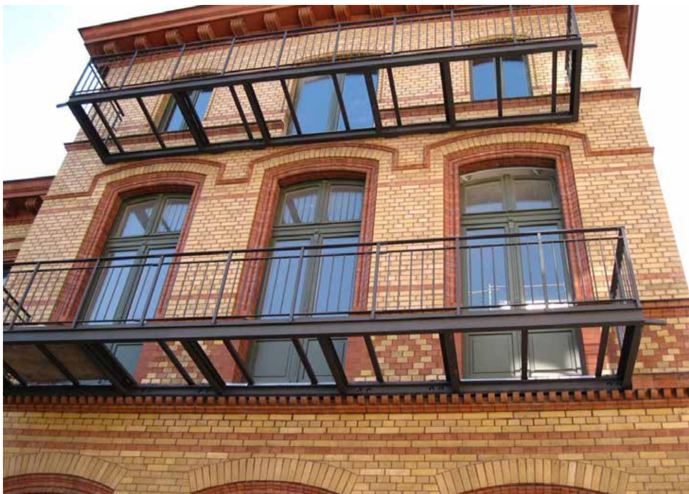
Abb. 3: Thermisch getrennter Stahlbalkon an historischer Fassade
