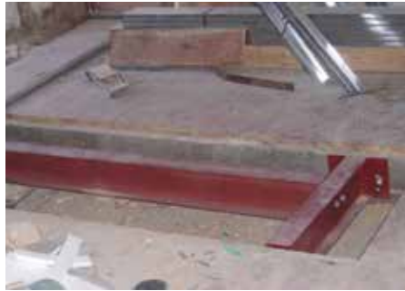
Abb. 1: Rückverankerung des Balkons in die Holzbalkendecke
