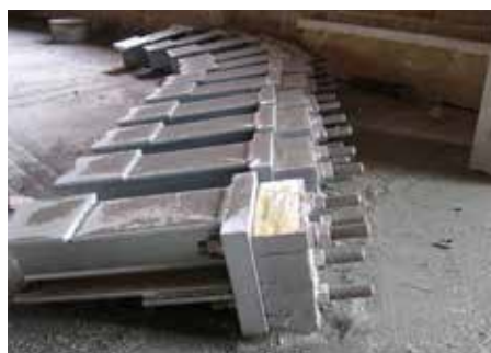
Abb. 1: neuer Balkonanschluss mit Isokorb® T S
