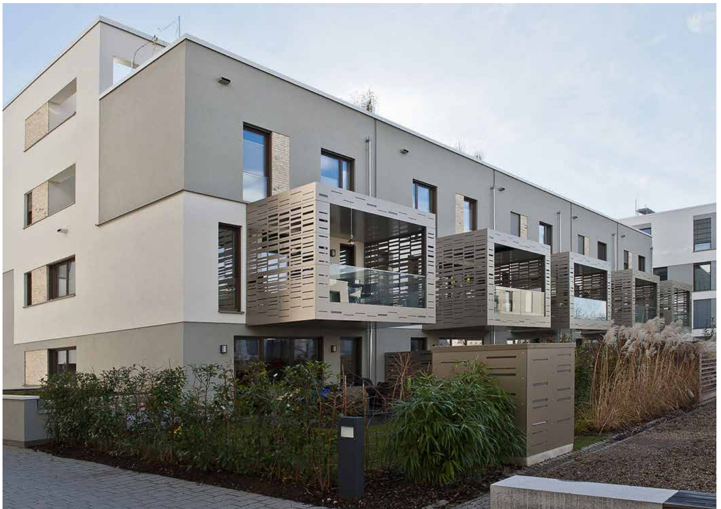
Abb. 3: WohnGut, Bahnstadt Heidelberg, Fischer Architekten GmbH
