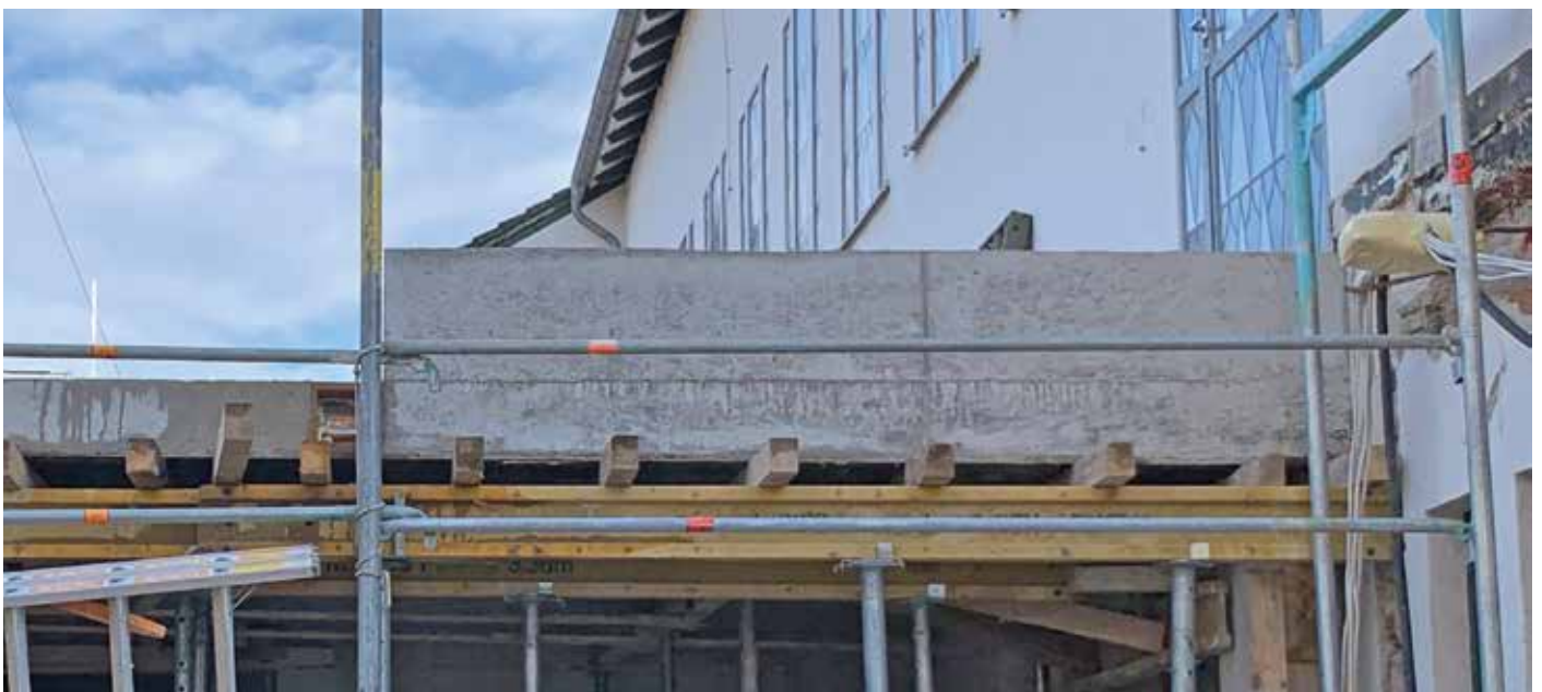
Abb. 6: Ausgeschaltete Attika nach der Betonage
