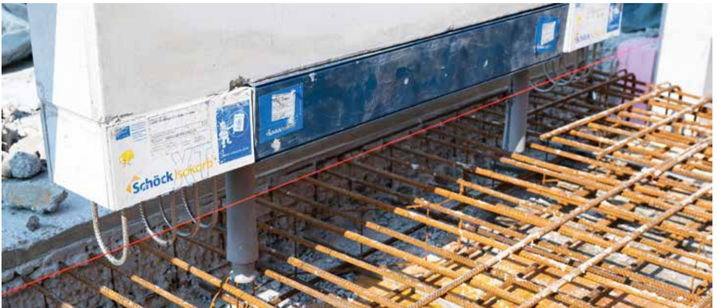
Einbau der Fertigteilattika auf der Baustelle
