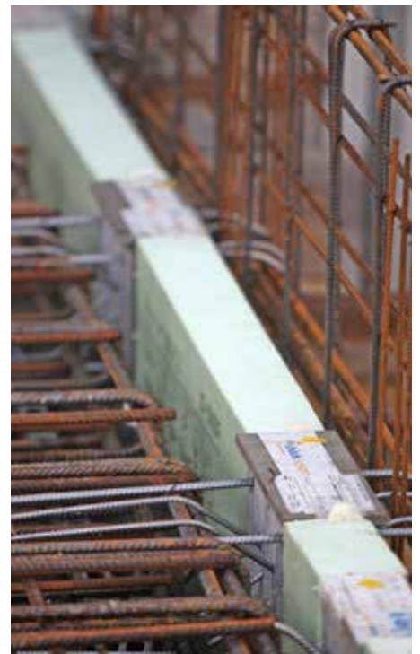
Abb. 5: Erstellen der Attika-Bewehrung
