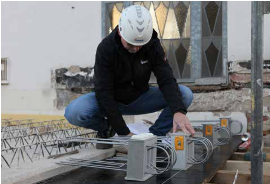
Abb. 2: Fixieren des Typ F mit Montageschaum
