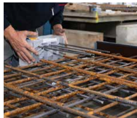
Abb. 2: Isokorb® CXT/XT Typ A einbauen
