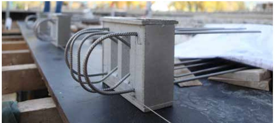
Abb. 1: Positionieren des Typ F am Deckenrand
