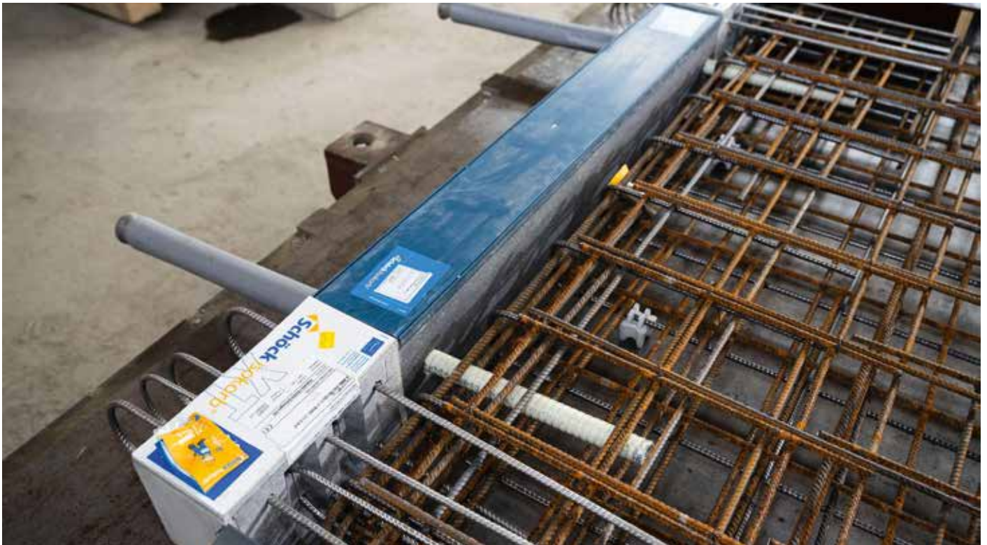
Einbau des Isokorb® Typ A mit Typ Z und Combar® FT-Montagestütze im Fertigteilwerk, Typ Z um 90° gedreht
