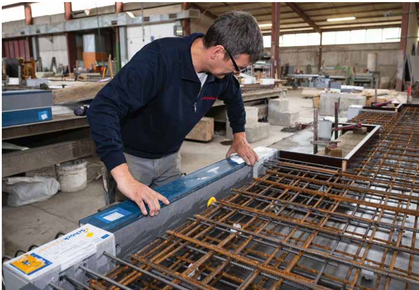
Abb. 3: Dämmzwischenstück Isokorb® Typ Z um 90° gedreht einsetzen
