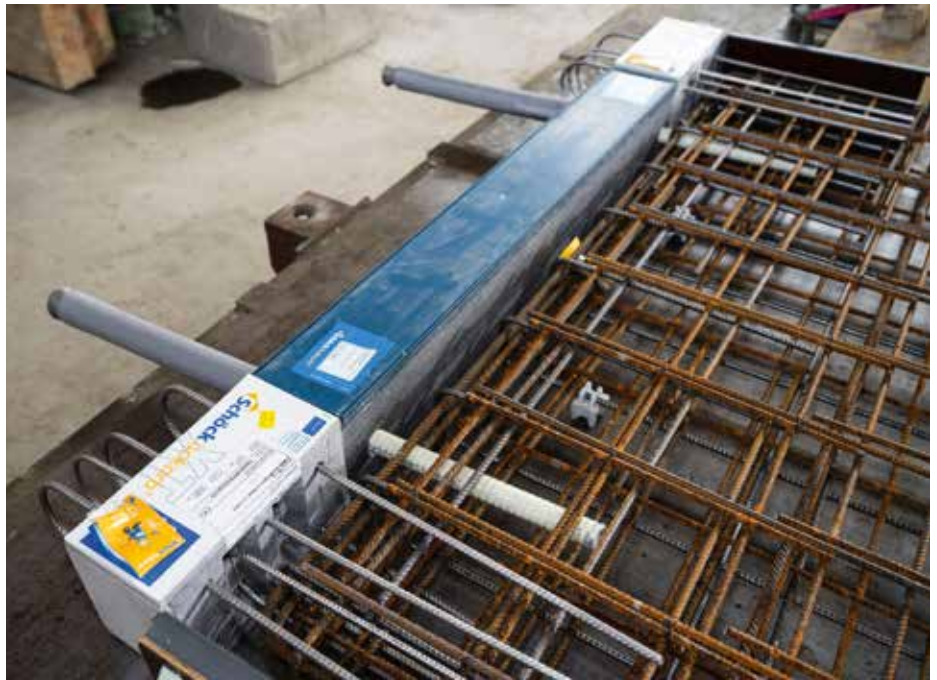
Abb. 5: Isokorb® Dämmzwischenstück und Montagestütze
