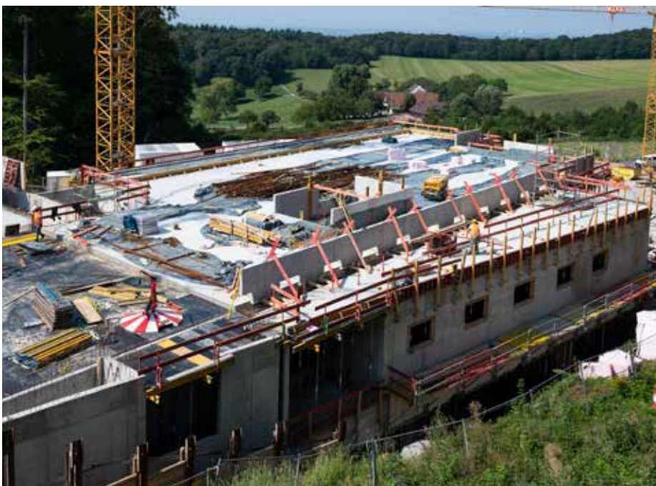
Abb. 5: Betonieren der Decke
