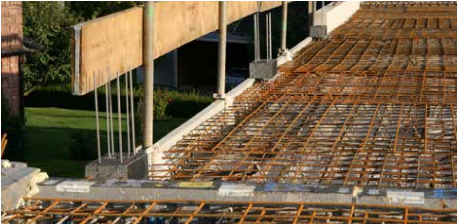
Isokorb® XT Typ A in Deckenbewehrung
