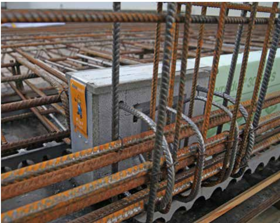
Abb. 4: Fixierung der Attika-Horizontalbewehrung
