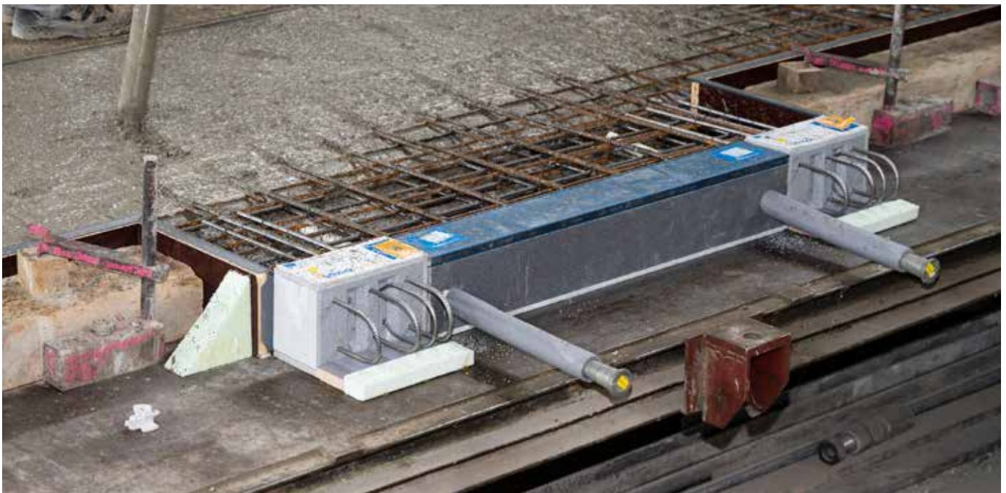
Abb. 6: Betonieren und verdichten
