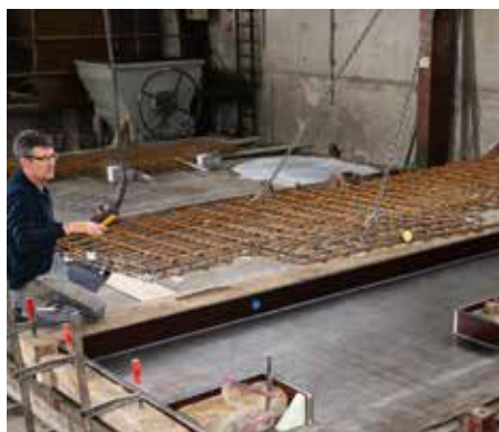
Abb. 1: Schalung für Fertigteil herstellen
