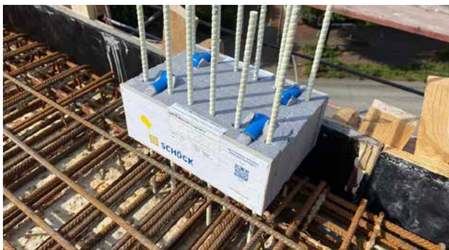
Abb. 1: Isokorb® in Bewehrung einstellen und fixieren
