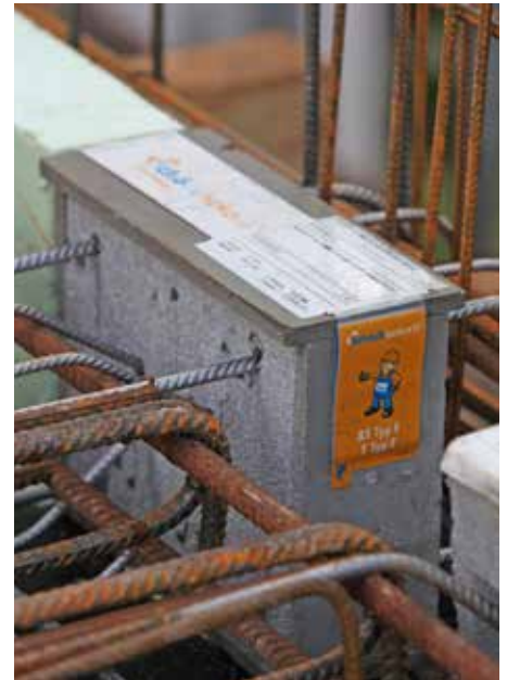
Abb. 3: Einbringen der Zwischendämmung
