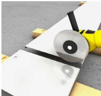
Abb. 2: Schneid- und Trennarbeiten Schneid- und Trennarbeiten gemäß des Arbeitsschutzes vornehmen. Bsp.: Bodenkanal-Deckel BKD 30.
