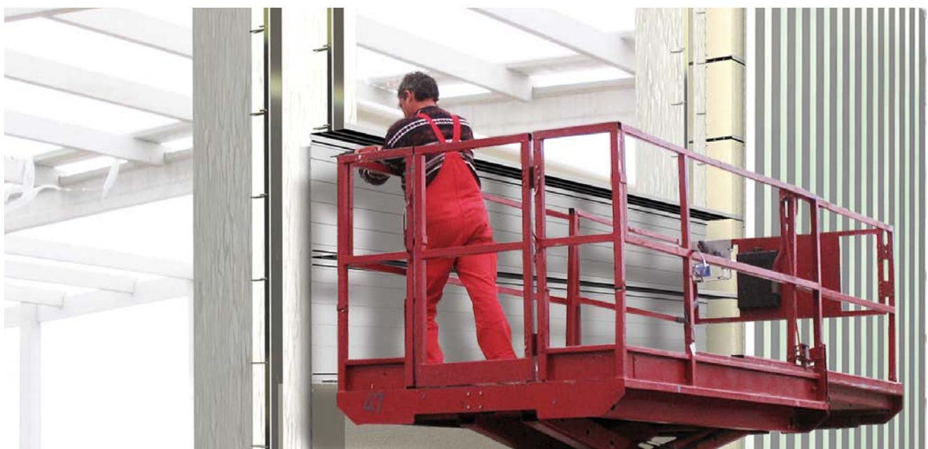
Montage einer mehrlagigen isolierten Trapezblech-Wand.
