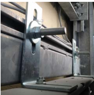
Befestigung von Aufzugstüren in einem Gitterträgerschacht
