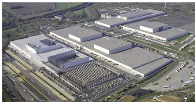
Befestigung auf dem Dach
