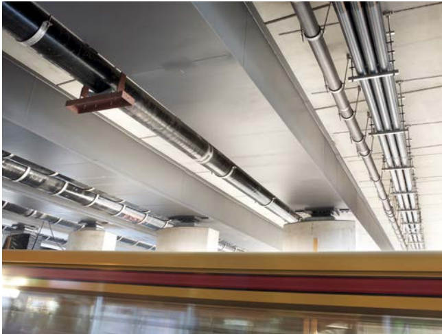
Spandauer-Damm-Brücke in Berlin, Deutschland
