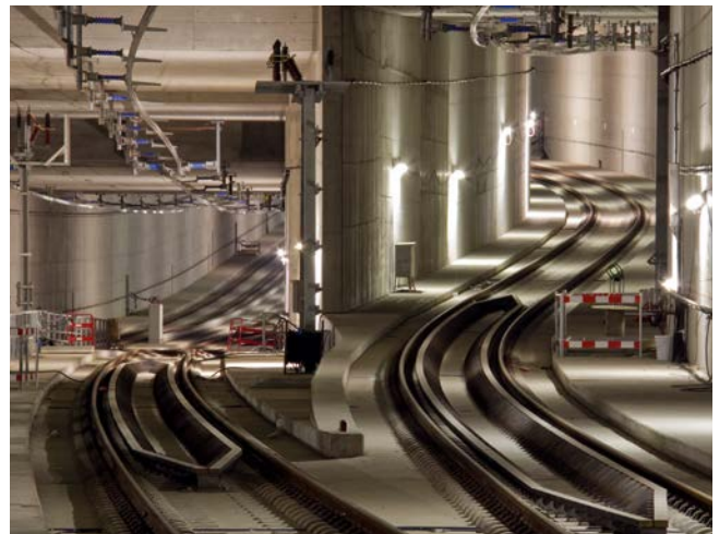
City-Tunnel Leipzig, Deutschland
