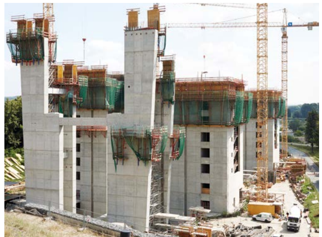
Schiffshebewerk Niederfinow, Deutschland
