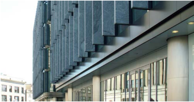
Vorgehängte Fassade am Metropolitan in Polen
