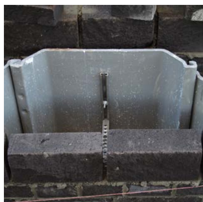
Anschluss von Verblendmauerwerk an Spundwand
