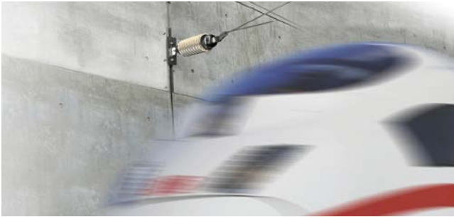
Oberleitung im Tunnel
