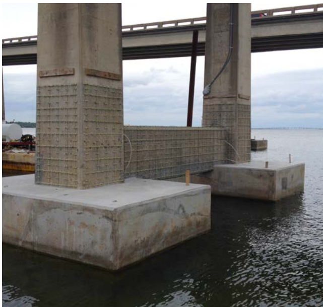
Sanierung von Brückenstützen im Salzwasser Florida, USA
