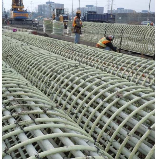
Bewehrungskörbe aus FIBERNOX® V-ROD mit geraden Stäben und Wendelbewehrung
