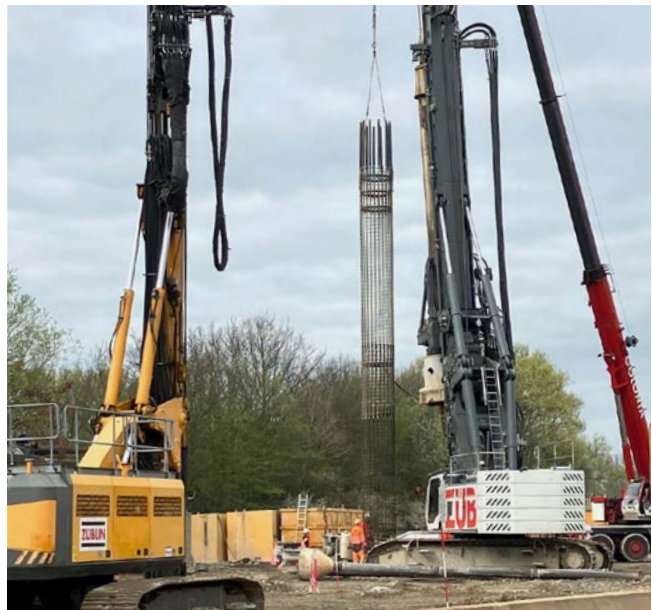
Bohrpfahl- und Schlitzwandbewehrung, Projekt Rheindüker, Köln
