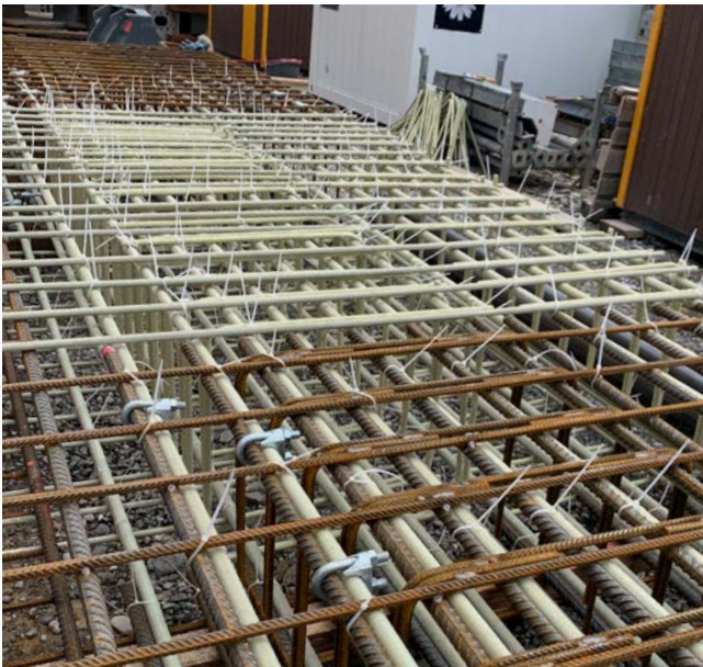
Schlitzwandbewehrung Autobahneinhausung Schwamendingen, Schweiz
