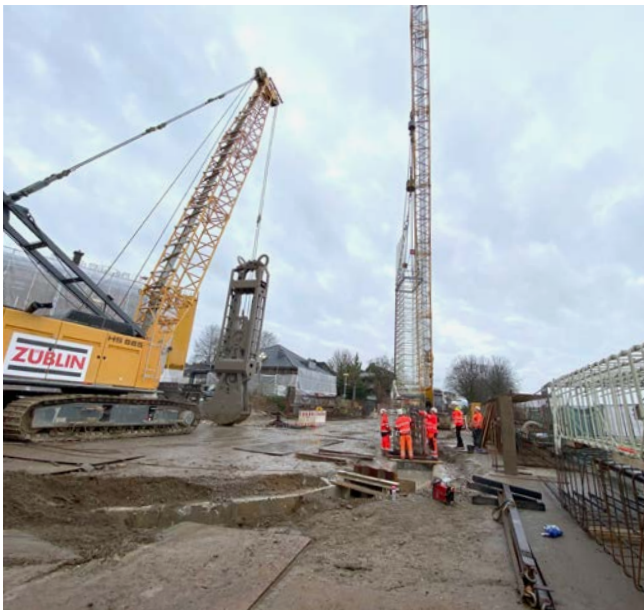
Bohrpfahl- und Schlitzwandbewehrung, Projekt Rheindüker, Köln
