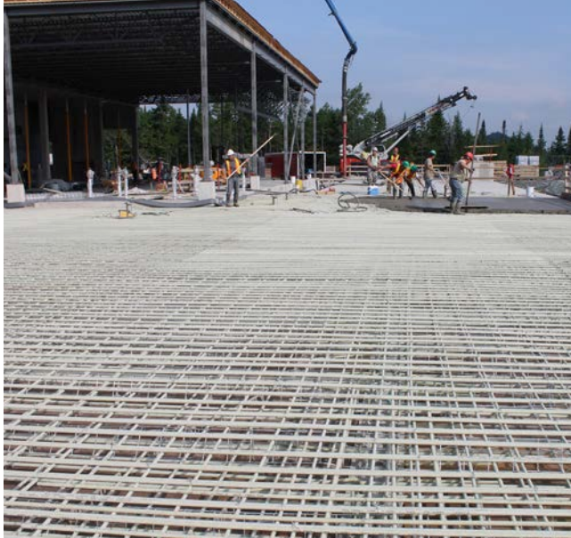
Tanks für Kläranlage, Bodenplattenbewehrung Thetford Mines, Québec, Kanada
