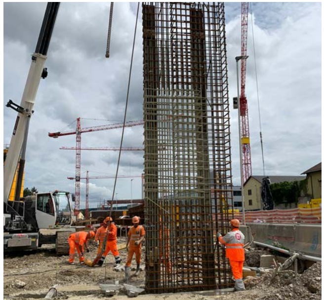
Schlitzwandbewehrung Autobahneinhausung Schwamendingen, Schweiz
