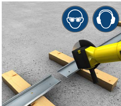
Abb. 2: Schneid- und Trennarbeiten Schneid- und Trennarbeiten gemäß des Arbeitsschutzes vornehmen. Bsp.: Gitterbahndeckel GD 06.
