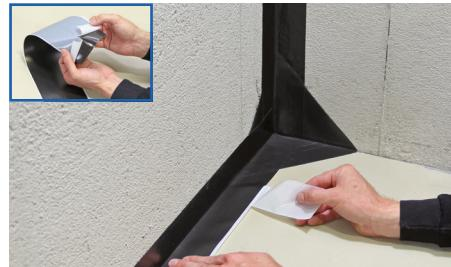
**3** Le ruban BLANKE DISK TAPE doit être placé dans toutes les zones d'angle horizontales et verticales. Enlever d'environ 5 cm le film protecteur en arrière sur un côté latéral, appliquer le ruban d'angle sur le support et presser à la main tout en tirant en arrière sans laisser de bulles. Répéter cette étape de travail.
