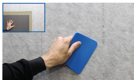
**7** Om reststukken van de BLANKE DISK afdichtbaan in het oppervlak te kunnen verwerken, moet de BLANKE DISK TAPE in een hoek van 90° met de bestaande afdichtbaan op de vriesvrije zone worden geplaatst. Aansluitend moet het stootbereik van de beide afdichtbanen met minstens 5 cm overlapping op BLANKE DISK TAPE worden aangebracht.
