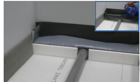
**3** BLANKE DISK-LINE mit einem Gefälle von 2 % an die Hausentwässerung anschließen und auf Dichtheit überprüfen. Schutzkern im Anschluss in die Linienentwässerung einsetzen.
