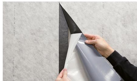
**6** D'autres bandes d'étanchéité doivent toujours être appliquées dans les zones exemptes de non-tissé de la bande d'étanchéité BLANKE DISK et, le cas échéant, être pressées à la main sans laisser de bulles.
