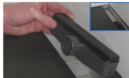
**8** Schutzkern entfernen und den Siphon von innen in die BLANKE DISK-LINE einstecken. Im Anschluss Rostrahmen mit den mitgelieferten Rosterhöhungsstücken oberflächenbündig einsetzen und den Rostrahmen dauerelastisch mit neutralvernetzendem Silikon zu den Wand- und Bodenfliesen versiegeln.
