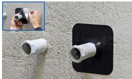
**4** Il est nécessaire de faire également l'étanchéité des passages de tubes avant la pose de la bande d'étanchéité au moyen des manchons de paroi et de sol BLANKE DISK WM/BM. Il faut en outre veiller à la formation correcte du bourrelet de la garniture d'étanchéité à l'extension de tube.
