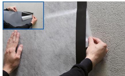
**5** L'étanchéité de surface se fait au moyen de la bande d'étanchéité BLANKE DISK. Retirer le film protecteur détaché en arrière d'environ 5 cm sur la partie étroite, appliquer la bande sur le support et en retirant progressivement en arrière le film protecteur, presser à la main sans laisser de bulles.
