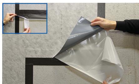
**7** Pour pouvoir travailler les chutes de la bande d'étanchéité BLANKE DISK en surface, il faut appliquer le ruban BLANKE DISK TAPE sous un angle de 90° par rapport à la bande d'étanchéité en place dans la zone libre de non-tissé. Pour terminer, la zone de jointure des deux bandes d'étanchéité doit être aménagée avec un chevauchement de 5 cm minimum du BLANKE DISK TAPE.
