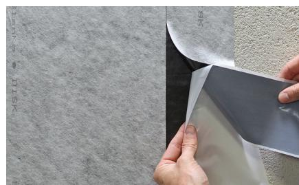
**8** Étant le dernier élément, la bande de bordure V DISK AB est placée sur la zone de chevauchement restante de la bande d'étanchéité exempte de non-tissé. A ce stade, il faut également détacher le film protecteur sur 5 cm, appliquer la bande de bordure et presser à la main en retirant en arrière sans laisser de bulles.
