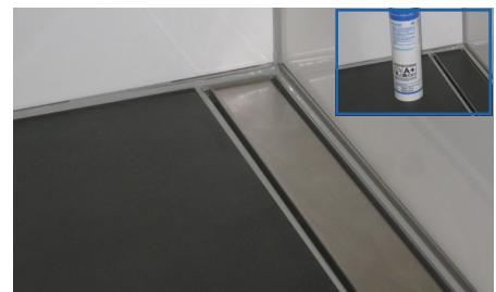
**9** Rostabdeckung in den Rostrahmen einsetzen. Für eine gefliesten Ausführung ist in die Rostabdeckung rückseitig ein Fliesenstreifen mittels BLANKE DIBA-COLL zu kleben und in den Rostrahmen einzusetzen. Die Fliesenstärke darf zehn Millimeter nicht überschreiten.
