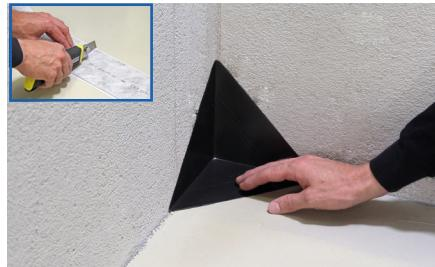
**2** Le BLANKE DISK se découpe au moyen d'un cutter. Tous les éléments d'angle sont pourvus de lignes d'aide au découpage. Les éléments d'angle BLANKE DISK CORN I/A doivent se monter en arrachant les films de protection arrière et en appliquant sur le support. Dans le cas des angles intérieurs, c'est la grande surface adhérente qui adhère au sol.
