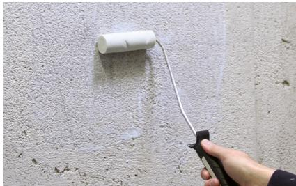
**1** Les supports doivent être secs, résistants à la charge et exempts de couches réduisant l'adhérence. La planéité doit être conforme à la norme DIN 18202. Les surfaces murales et de sol doivent être pourvues d'une couche primaire appropriée à leur consistance. Il est nécessaire de prendre en compte les indications du fabricant pour le temps de séchage.
