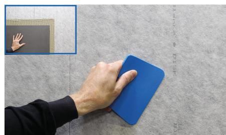
**9** Après établissement de l'étanchéité composite, il faut presser le BLANKE DISK au moyen de l'applicateur BLANKE DISK Tool fourni, afin d'obtenir une adhésion optimale de tous les composants avec le support. Après quoi, le carrelage ou le revêtement en pierres naturelles peut être réalisé selon le procédé à bain mince.
