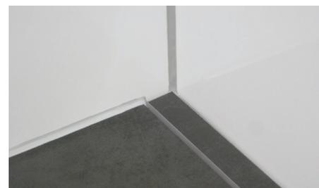
**9** Abdeckfolie am beiliegendem Vliestape entfernen und auf das gereinigte Edelstahlrost aufkleben. Fliesen zuschneiden und mit BLANKE DIBA-COLL auf dem Vliestape verkleben. Höhenausgleich zu den Bodenfliesen erfolgt über rückseitige Gewindeschrauben.
