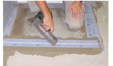
**6** Eck- und Anschlussbereich sind zusätzlich über die BLANKE DIBA Systemkomponente Corn I bzw. A, DIBA-Keil und Dichtbänder sicherzustellen. Die Verklebung erfolgt mittels BLANKE DIBA-COLL.
