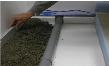
**4** An allen aufsteigenden Bauteilen ist ein Randdämmstreifen zu setzen. Fachgerechten Estrich einbringen und die Oberfläche bündig mit dem Installationsblock abziehen. Die breite Seite des Installationsblock ist als Abziehlehre zu verwenden. Ein Gefälle von 2% ist einzuhalten.
