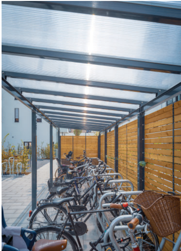
Fahrradüberdachung mit Stegdoppelplatten-Dach.
