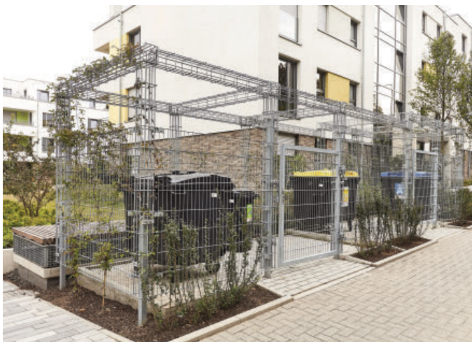
Müllplatz , Tragkonstruktion Drahtbalken.
