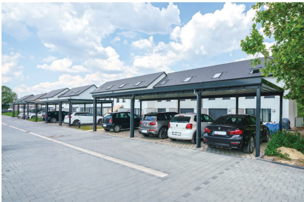
Carportanlage , Tragkonstruktion nach RAL 9016 Anthrazit pulverbeschichtet, , Trapezblechdachendeckung.
