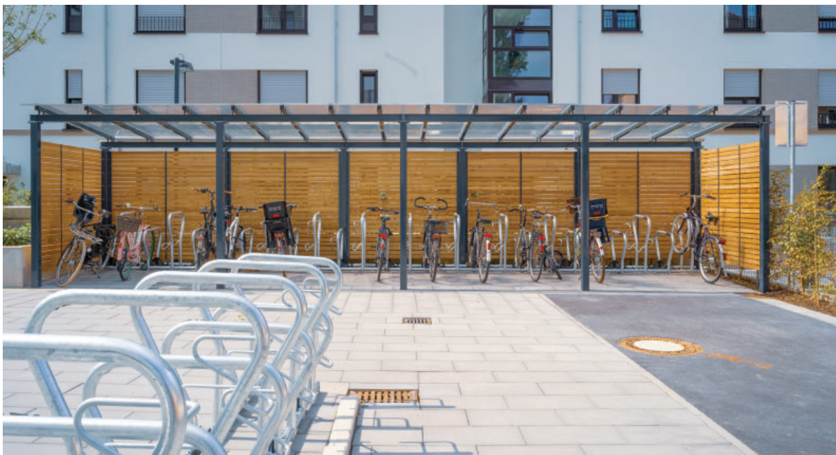
Fahrradüberdachung , Stützen nach RAL 7016 Anthrazitgrau pulverbeschichtet, Seitenverkleidung Woodline, Dacheindeckung Stegdoppelplatten.
