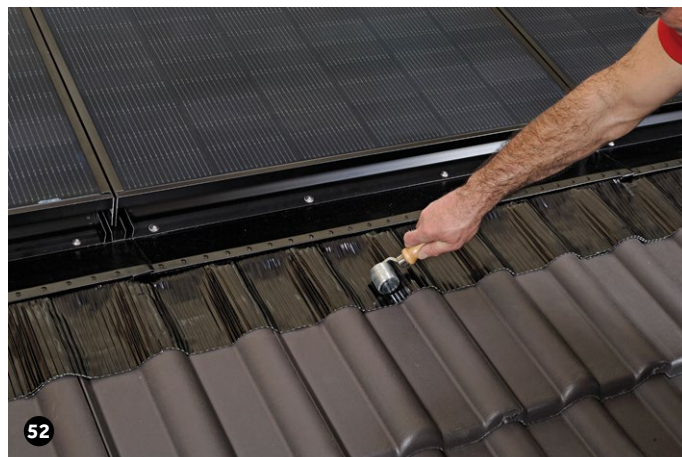
Die plissierte Schürze an die Kontur der Dachpfannen anrollen.
