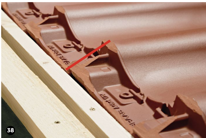
38 Bei höher profilierte Dachpfannen in Kombination mit geringen Dachneigungen müssen die Pfannen im Kopfbereich angeschrägt werden, um Hinterschnitte und damit Wassersäcke an der Schürze zu vermeiden.
