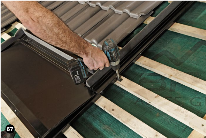
67 Befestigung von Seitenteil und Unterteil mit Haften.
