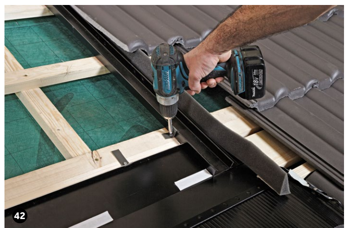
42 Unteres und seitliches Eindeckblech mit Haften befestigen.
