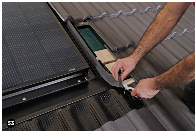
Die Schutzfolie von den seitlichen Schaumstreifen abziehen und den Schaumstreifen auf der Schürze festkleben.
