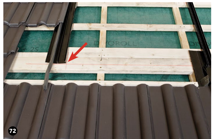
72 Das seitliche Eindeckblech links unten ebenfalls an der horizontalen Abschnürung auf der Hilfsbohle ausrichten.
