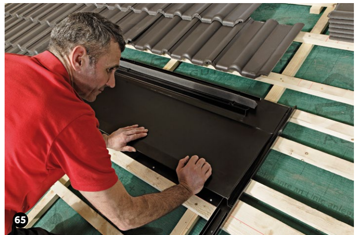
Das komplette Unterteil N in die entsprechende Position bringen. Der Einbau erfolgt analog zu den oberen Eindeckblechen 7.7.4
