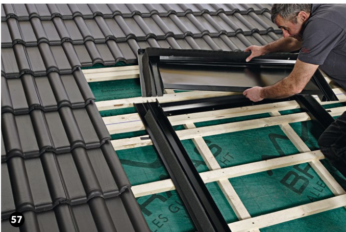
Nach dem Einbau der seitlichen Abdeckbleche und der Firstbefestigung das obere Eindeckblech einspaltig einsetzen. Der Einbau erfolgt analog zu den oberen Eindeckblechen 7.7.4
