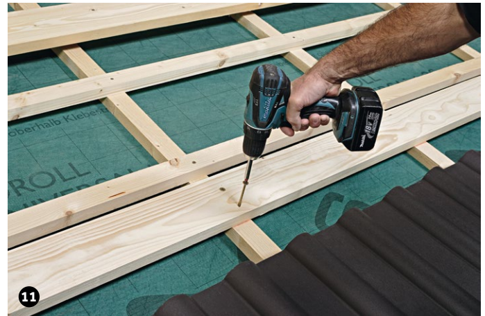
Hilfsbohlen montieren. (Querschnitt siehe Tabelle Bemessungslasten und Befestigungsvarianten Seite 3) Befestigung mit Würth ASSY plus 6,0 x 120 mm. Bei Aufsparrendämmung oder Schalung entsprechend längere Schrauben verwenden.
