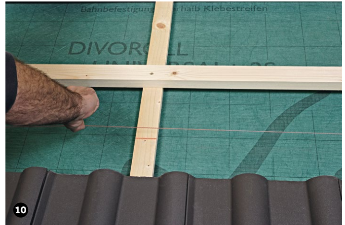
Positionen der Hilfsbohlen und Hilfslatten auf der Konterlatte abschnüren
