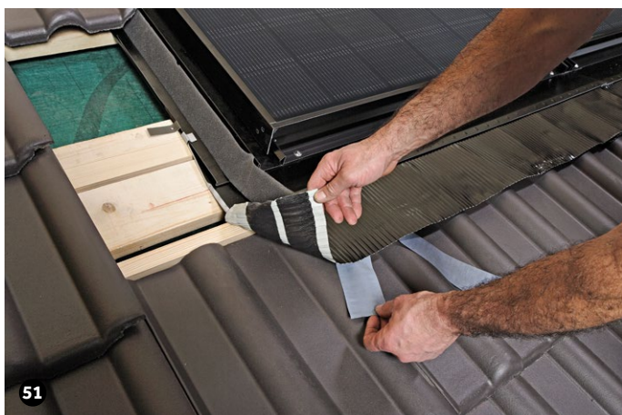
Für die Verklebung der Schürze müssen die Dachpfannen sauber, staubfrei und trocken sein. Die untere Schutzfolie abziehen.
