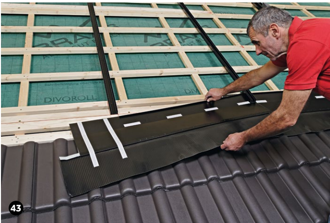
Das nächste Eindeckblech verlegen.
