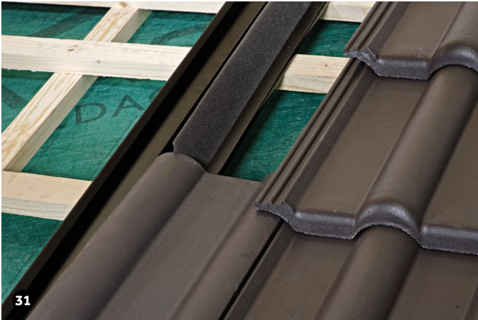
31 Über jeder Dachpfanne den Schaumstreifen einschneiden, um die Lücke unter dem Versatz zu schließen.
