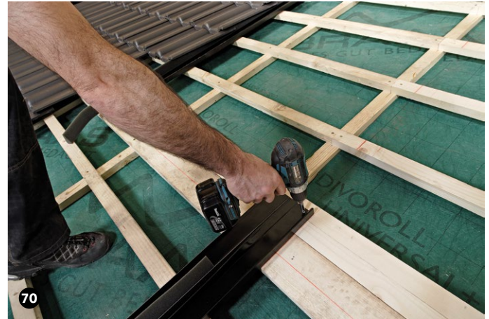
70 Beschreibung anhand der Spezial-Ecke D. Die Verlegung der Spezial-Ecke C erfolgt sinngemäß. Das Seitenteil U entsprechend Abschnitt 7.7.1 befestigen.
