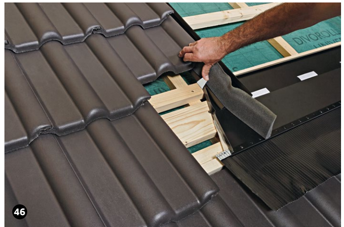
Die unteren Eindeckbleche links und rechts durch Umbiegen der Laschen am seitlichen Eindeckblech sichern.
