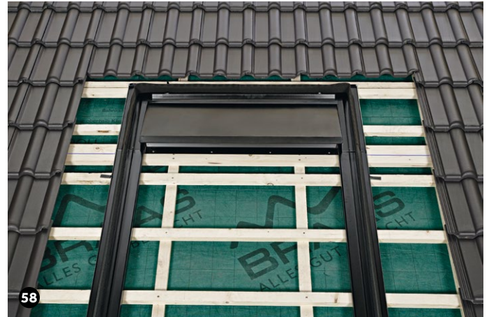
Fertig eingebauter firstseitiger Anschluss
