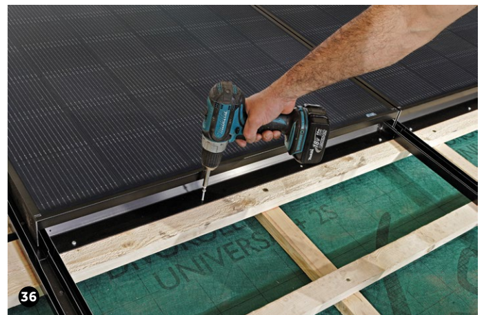
36 Modul auf Hilfsbohle anschrauben (Schrauben gemäß Befestigungsvariante Tabelle Bemessungslasten und Befestigungsvarianten Seite 3)
