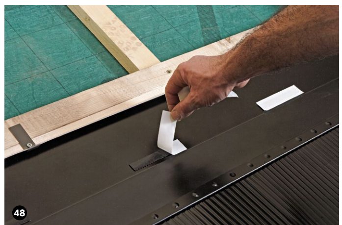
Die Klebestreifen von den Butylkleber-Pads entfernen
