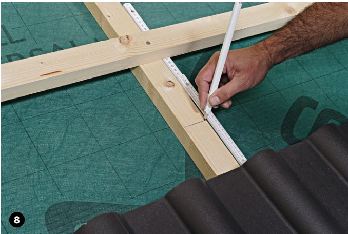
Den Abstand Unterkante Hilfsbohle von Oberkante der stehenden Hilfsbohle Dachpfannen-Kante markieren: 90 mm
