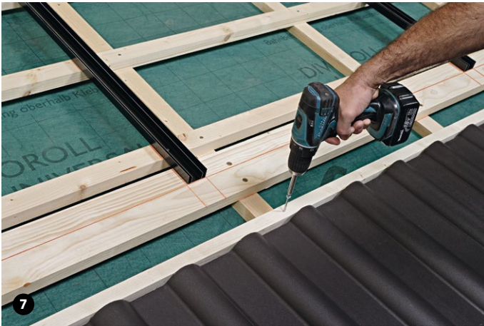
Als Startpunkt und spätere Auflage für die unteren Eindeckbleche eine Hilfsbohle hochkant oberhalb der Dachpfannen verlegen. Höhe: Traglattenhöhe + 2 cm
