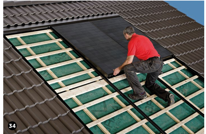
34 Module ganz nach oben schieben.
