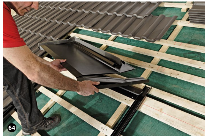
Die beiden Teile des Unterteils N zusammenstecken.
