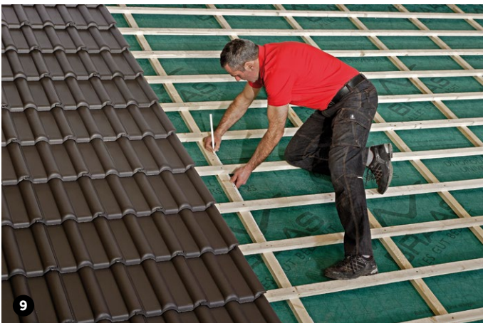
Positionen für die weiteren Hilfsbohlen und Hilfslatten anzeichnen. Abstand Hilfsbohlen untereinander: 1.740 mm
