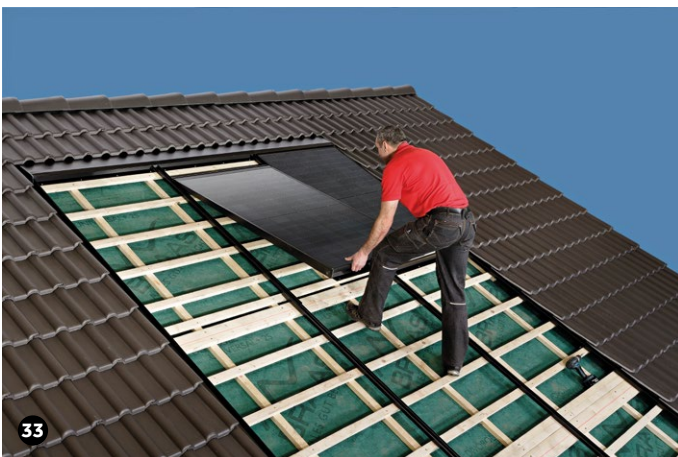
33 Die Module zeilenweise verlegen. Mit der obersten Reihe beginnen. Das zu verlegende Modul mit der Oberkante zwischen die Drainagenschienen einlegen etwas anheben, in die Firstbefestigung einschieben und danach absenken.
