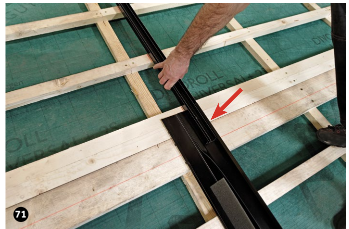
71 In das Seitenteil U eine Drainage-Schiene einschieben. Die Unterkante liegt an der horizontalen Abschnürung auf der Hilfsbohle. Die Drainage-Schiene firstseitig befestigen.
