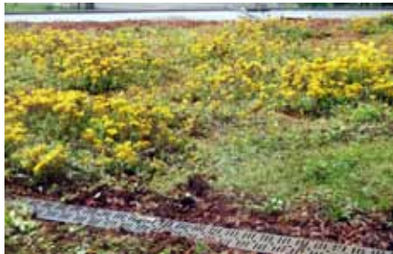
innenliegende Entwässerungsrinne
