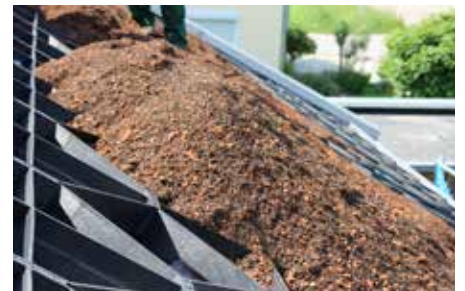
Die Systemerde „Lavendelheide-Leicht“ wird z. B. im Silozug angeliefert und per Schlauchleitung solange auf das Dach geblasen, bis die Georaster®-Elemente ca. 1 cm überdeckt sind.
