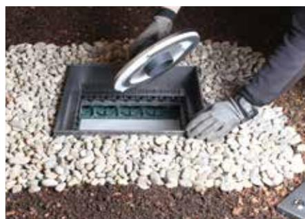
Das Retentionsdrossel-Set RDS 28 eignet sich für alle Flachdachabläufe mit angeschäumter Anschlussbahn.
