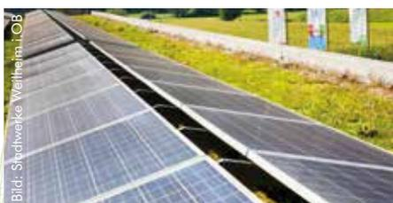
Beim Aufständerungssystem „Sattel“ werden zwei Grundrahmen so auf einer SB 200-Platte verschraubt, dass die beiden Grundrahmen mit ihrer höheren Seite aneinanderstoßen.
