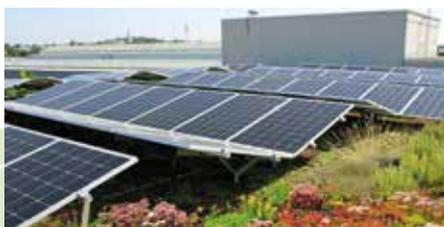
Bei der Variante „Schmetterling“ stoßen die beiden Grundrahmen mit der niedrigen Seite aneinander, so dass Niederschlagswasser mittig auf die SB 200-Platte geleitet und dort in beide
