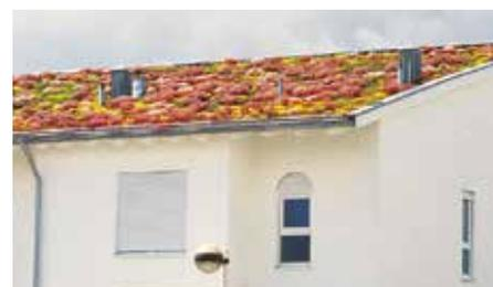
Bei diesem Pultdach wurde knapp oberhalb der Traufe eine Schubschwelle platziert. Die Entwässerung erfolgt über eine außen liegende Dachrinne.
