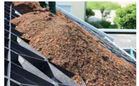
Die Systemerde „Lavendelheide-Leicht“ wird z. B. im Silozug angeliefert und per Schlauchleitung solange auf das Dach geblasen, bis die Georaster®-Elemente ca. 1 cm überdeckt sind.
