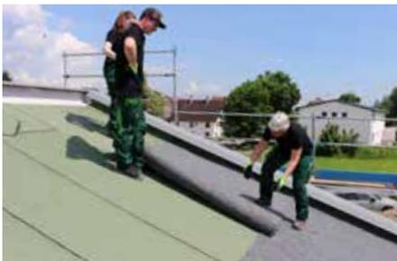
Die zu begrünende Dachfläche wird mit einer gemäß dem FLL-Verfahren auf Wurzelfestigkeit geprüften Dachabdichtungsbahn abgedichtet.
