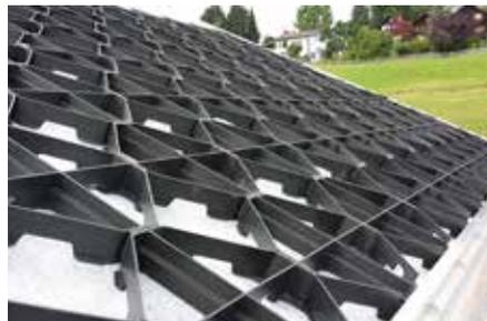
Nach Abdecken der Fläche mit der Wasserspeichermatte WSM 150 werden – beginnend von unten links – die Georaster®-Elemente verlegt.
