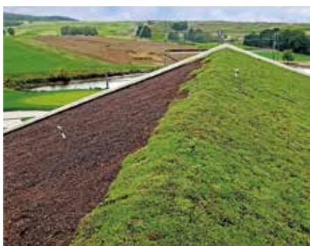
Für den Gründach-Systemaufbau kam die Bewässerungs- und Schutzmatte BSM 64 zum Einsatz und darüber die vollflächig verlegten Floraset® FS 75-Elemente, die speziell für geneigte
