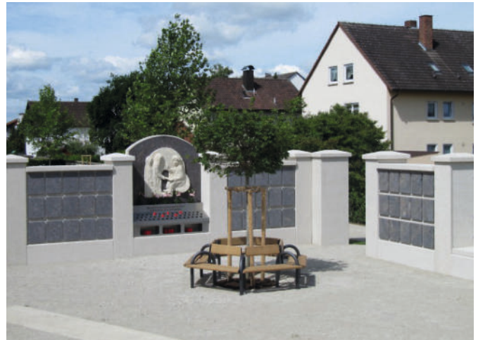
Gemeinde Bad Staffelstein Wertstein: Promitan®, Kammerverschlussplatten: Paradiso Bash
