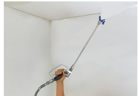
Stark auf der Großfläche: Auftrag von Rotband Reno M mit der PFT SWING Airless
