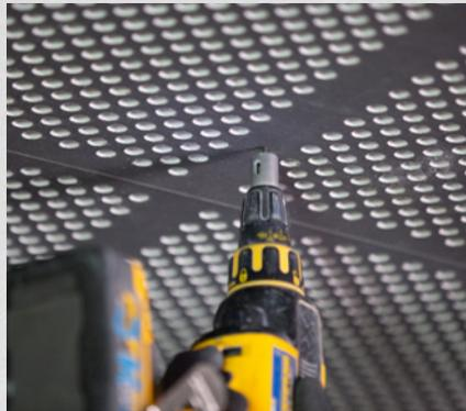
Cleaneo Klett Board einfach verschrauben – ganz ohne Spachtelaufwand. Platte und Cleaneo Klett Surface sind zudem getrennt demontierbar.
