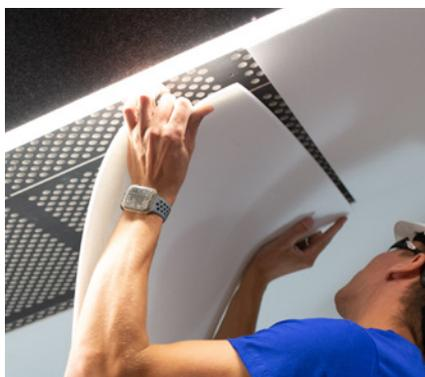
Die flächige Klettverbindung macht die Montage der akustisch wirksamen Cleaneo Klett Surface extrem einfach und jederzeit reversibel. Ergebnis: eine geschlossene Deckenfläche mit optimaler akustischer Wirkung.
