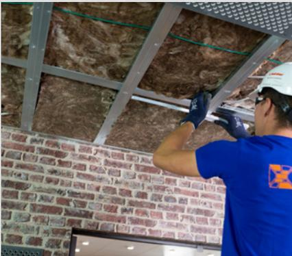
Bewährter Standardaufbau mit CD-Profil als Unterkonstruktion
