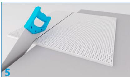
Die Profile werden zur Wand hin mit Abstand 2 – 3 mm eingestellt. Schneiden Sie die Platten mit einer feinzahnigen Säge zu. Die Kartonkante mit feinem Schleifpapier abschleifen.
