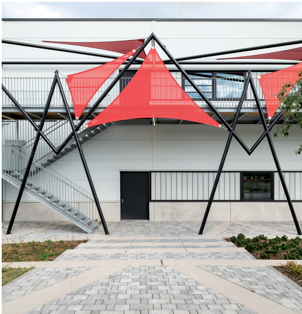
Camina-Halle, Neubau Produktionsstandort | Rathenow
