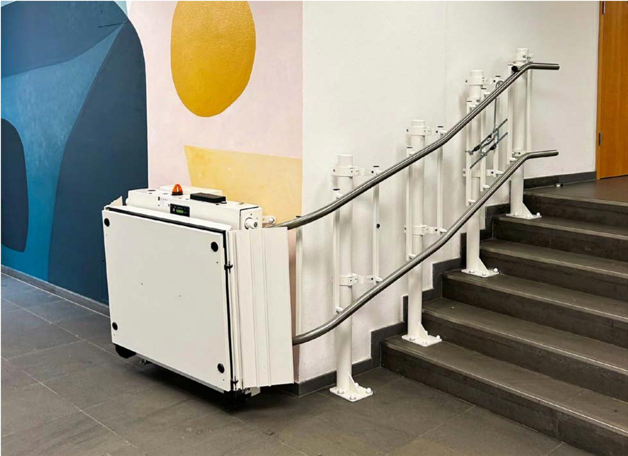
Da wir Ihnen eine Lösung anbieten möchten, die individuell auf Ihre Situation zugeschnitten ist, setzen wir keine vorgefertigten Fahrbahn-Kurventeile ein. Letztgenannte erlauben keine optimale Anpassung an die Fahrbahn-Ideallinie. Die Fahrbahn des HIRO 320 dagegen wird passgenau für Sie hergestellt und bietet deshalb unabhängig vom Treppentyp optimale, enge Kurvenradien. So bleibt der begehbare Platz Ihrer Treppe so weit wie möglich erhalten.
