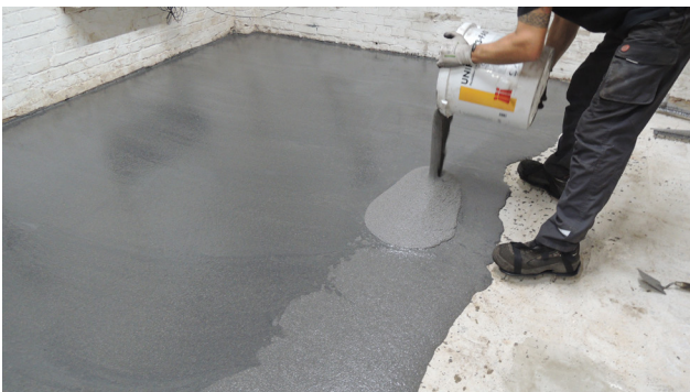
Praxisbeispiel Aufbringen einer fließfähigen Ausgleichsschicht auf Beton
