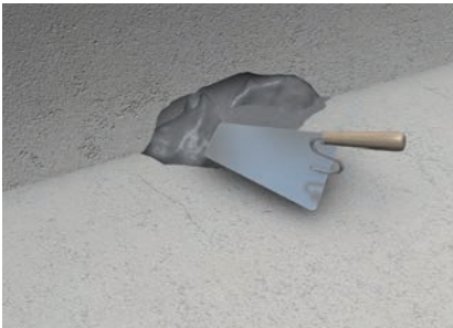
2. Ausbrüche ausgleichen Ausbrüche und Fehlstellen mit ASOCRET-BIS-5/40 im Spachtelverfahren schließen. Die Verarbeitung erfolgt „frisch in frisch“ auf die Haftschräume ASOCRET-HS-Flex.
