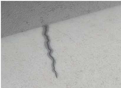
1. Rissanierung Risse fachgerecht beurteilen und schließen (siehe dazu die Kapitel zur Rissanierung).
