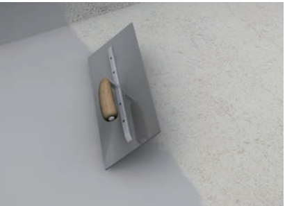
3. Fläche egalisieren ASOCRET-BIS-1/6 auf den vorbereiteten Untergrund in der gewünschten Schichtdicke (bis zu 6 mm in einem Arbeitsgang) auftragen und mittels Filz- oder Schwamm-brett nacharbeiten.
