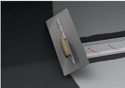
6. Flächen abdichten AQUAFIN-RB400 in mindestens zwei Arbeitsgängen im Spritz-, Streich- oder Spachtelverfahren auftragen.
