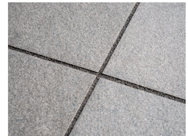
fertiges Fugenbild - Fugenfarbe grau
