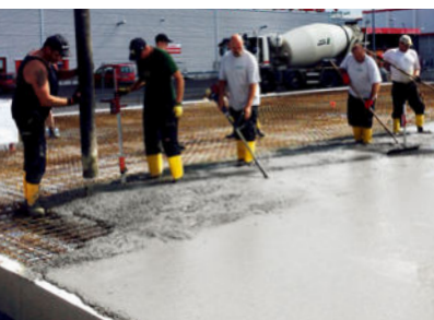
betonieren und verdichten
