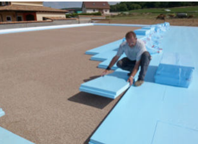
XPS-Wärmedämmung einbauen
