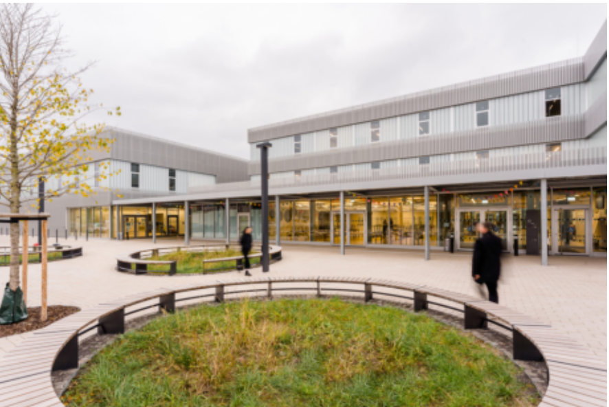
Offene Schule Köln - Hausmann Architek-
