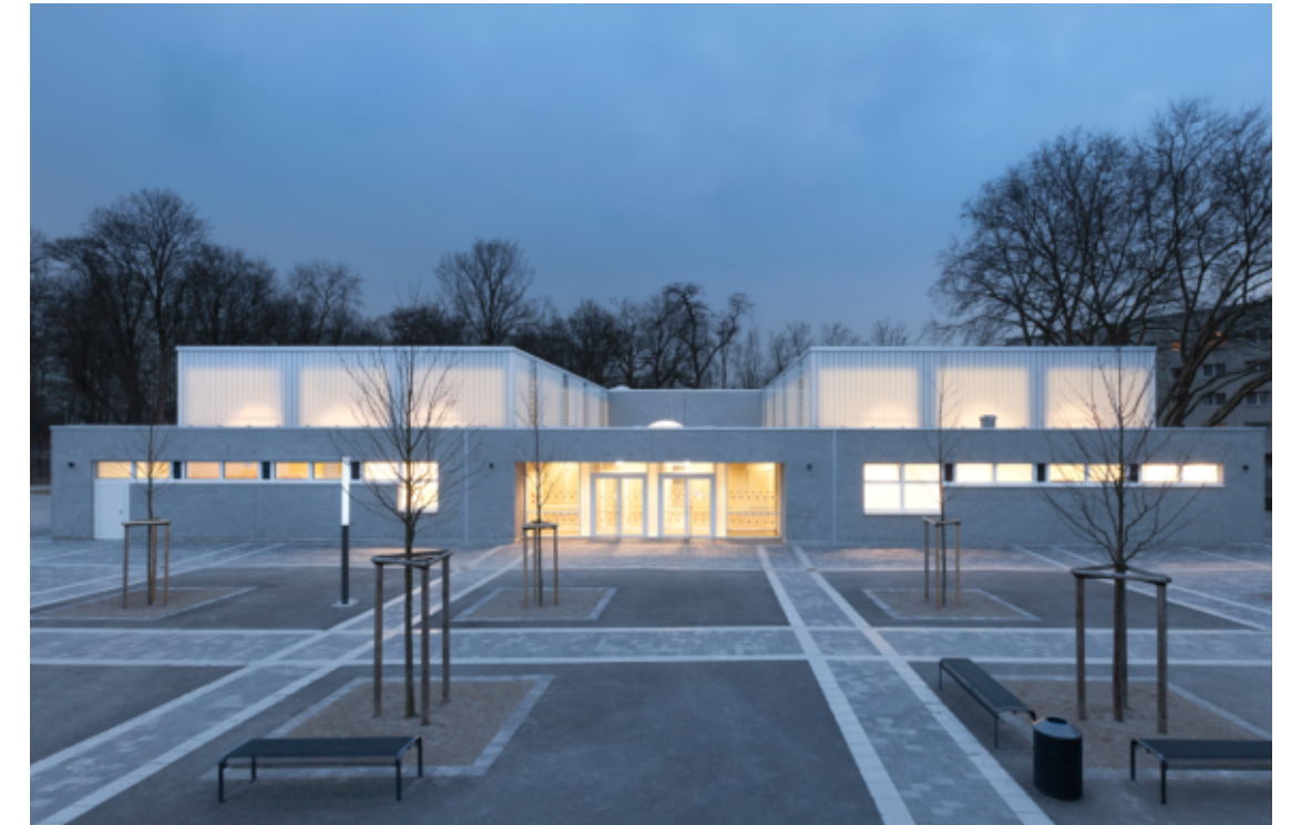
Turnhalle Görlinger Zentrum - Gebäudewirtschaft Köln
