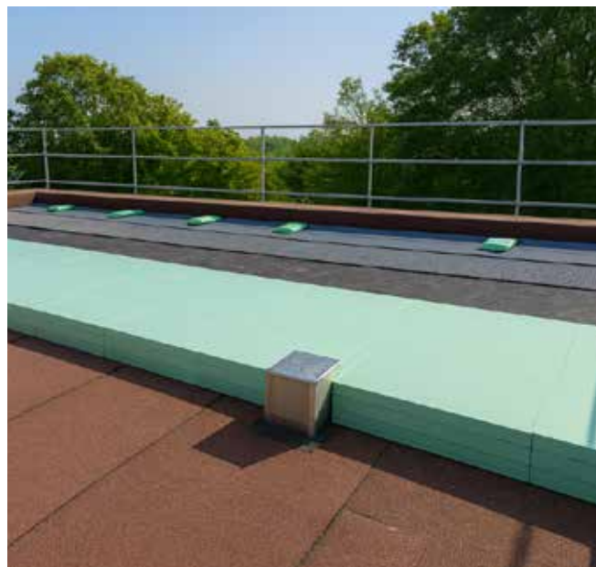
Abb. 1: Styrodur® ist aufgrund seiner Druckfestigkeit, geringen Wasseraufnahme und geringen Wärmeleitfähigkeit für UK-Dachkonstruktionen hervorragend geeignet, z. B. bei Flachdachsanierungen als Plus-Dach.
