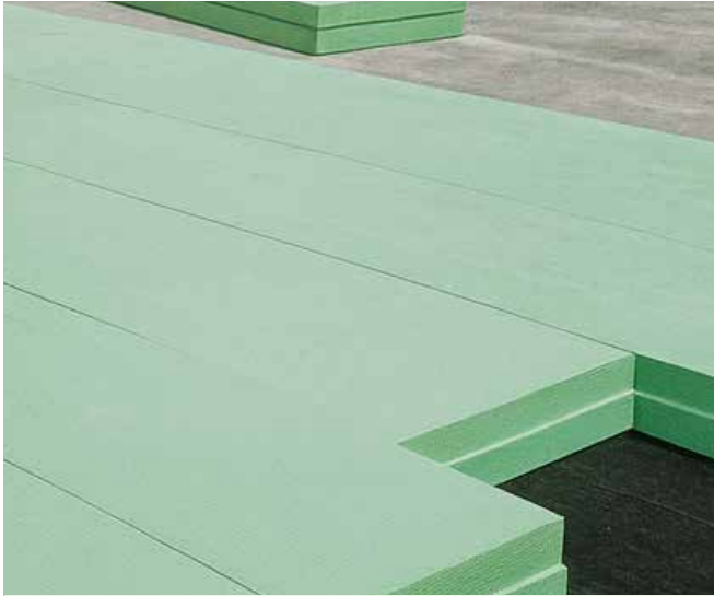
Abb. 13: Verlegung von Styrodur® oberhalb der Dachabdichtung.
