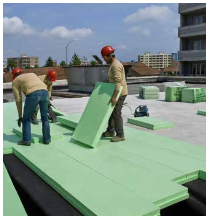
Abb. 7: UK-Dach mit Trennlage.
