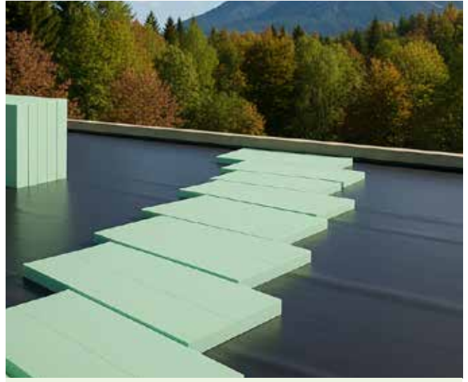
Abb. 14: Saniertes UK-Dach als Plusdachkonstruktion.
