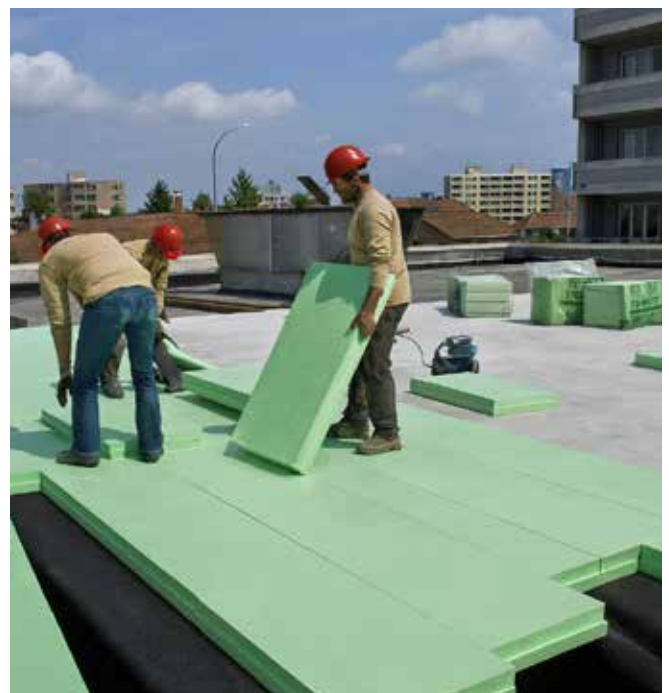
Abb. 7: UK-Dach mit Trennlage.
