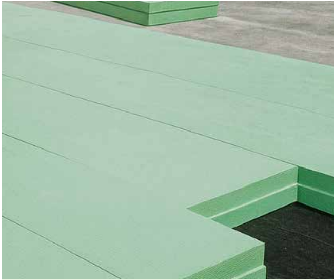
Abb. 13: Verlegung von Styrodur® oberhalb der Dachabdichtung.
