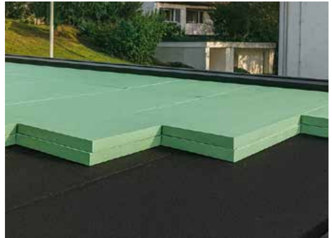
Abb. 23: Verlegung von Styrodur®-Platten unter extensiver Dachbegrünung.
