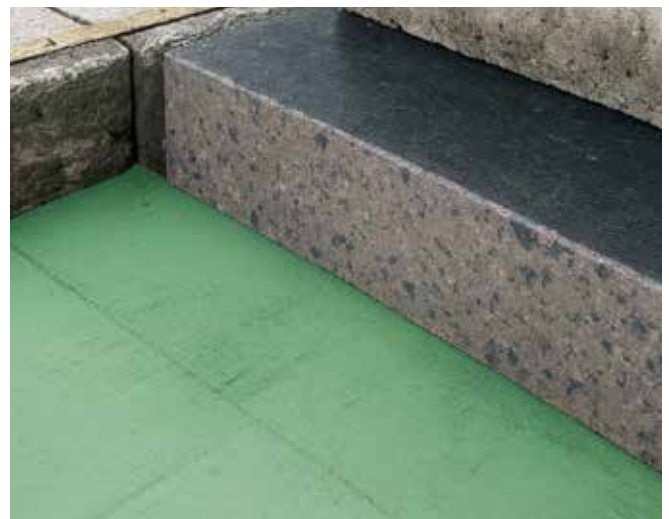
Abb. 45: Aufgeschnittene Ortbetonfahrbahnplatte zur wissenschaftlichen Untersuchung des Langzeitverhaltens.
