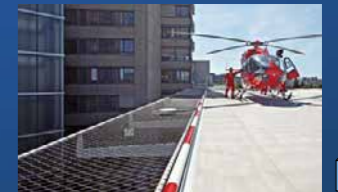
Heliport Inselspital Universitätsspital Bern (CH)
