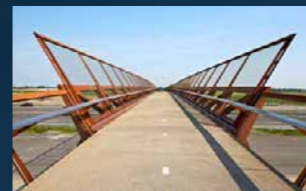
Bicycle bridge Hoofddorp (NL)
