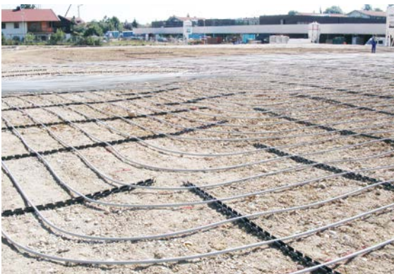
Abb. 05-2 Flächenverlegung
