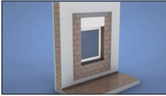
10 Blendrahmen inklusive Rollladenelement in der Rohbauöffnung platzieren und fixieren. Die Montage ist nach den anerkannten Regeln der Technik vorzunehmen. Der Rollladenkasten ist bei der Montage lot- und waagrecht auszurichten.
