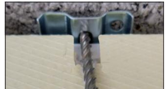
**Montagevorschlag:** Putzträger innen ausnehmen um die mit der Gewindeplatte (optional) verschraubten Montageschiene (bauseits) am Baukörper zu befestigen.
