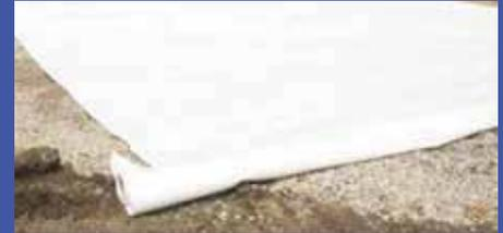
2. Verlegung einer Geotextilie, die auf der gesamten Baustellenfläche als Untergrund für GEOCELL.
