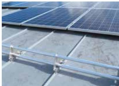
Doppelrohrhalter auf S-5!® E-Mini Klemme für Doppelstehfalz
