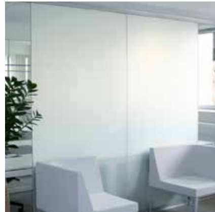
Vitrage sablé Gezandstraalde glaswand Sandgestrahltes Glas
