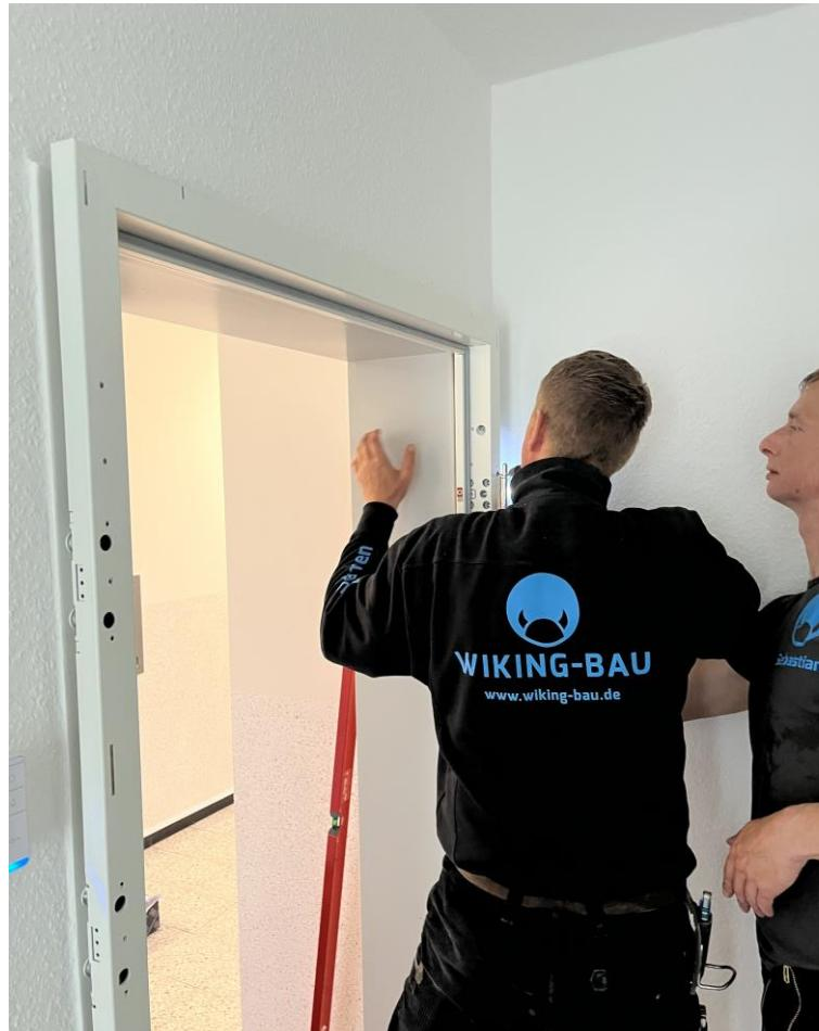
2. Daloc K40 Sanierungszarge auf die alte Stahlzarge setzen und mit Schrauben in der Tiefe verankern.
