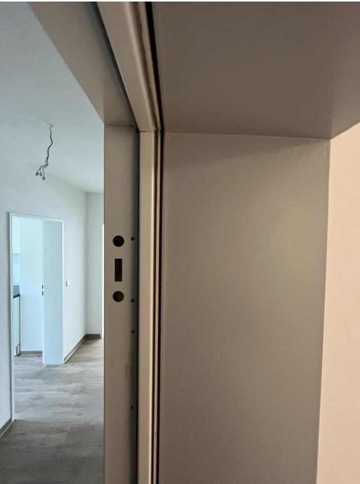
1. Vorbereiten der alten Stahlzarge durch Entnahme des alten Türblattes und der Scharniere.
